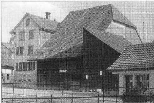
Blick vom Stadthaus zur Zehntenscheune und den Anbau mit dem Pultdach, in dem die erste Spritze untergebracht war.
