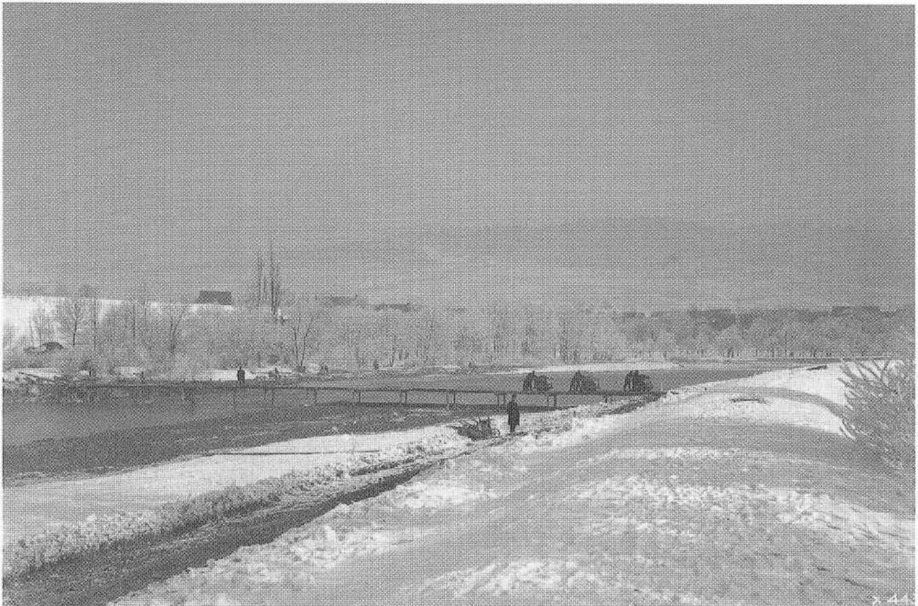
Auch bei Oberengstringen führte vorübergehend ein Hilfssteg über die Limmat. Der Dam ist bereits aufgeschüttet. Trotz des Schnees wird der Fuss des Dammes flussseitig mit Kalksteinen befestigt. Es gilt das extreme Niedrigwasser der Limmat auszumützen..
