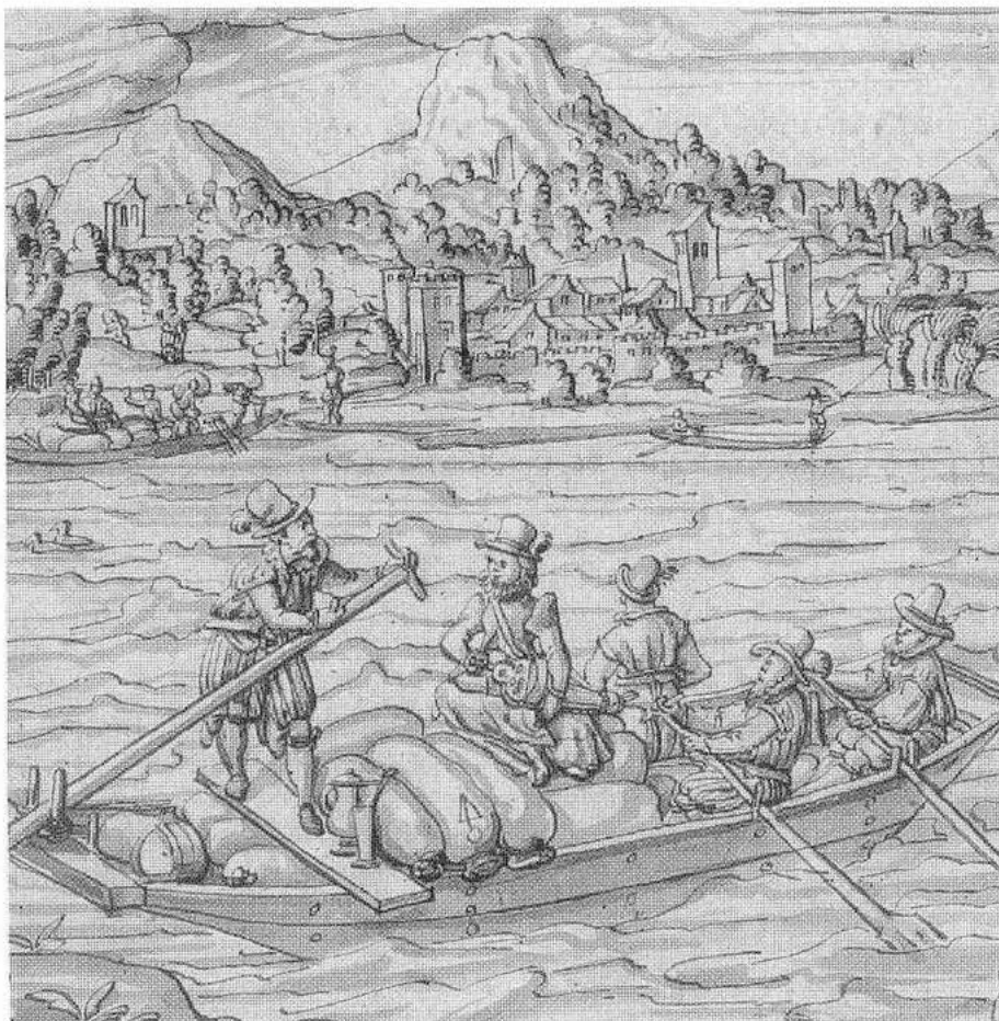
Ein Flussnauen mit Waren und zwei Fahrgästen. Dass nur einseitig gerudert wird, spielt keine Rolle. Den Kurs in der Strömung und durch die Strudel des Flusses bestimmt ohnehin der Mann am Heck, der das Boot mit einem Ruder steuert. Daher die Bezeichnung Steuer-«Ruder».
