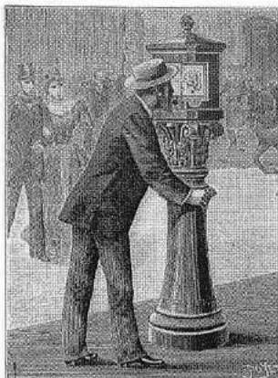
Schon 1893 existierte in Paris ein Feuermeldesystem von Rufsäulen über Telephon direkt in die Feuerwehrekaserne – mit automatischer Aufzeichnung über Morsetelegraf.
