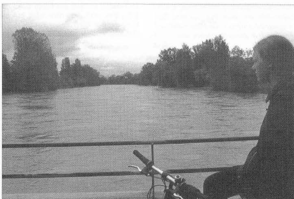
Das Hochwasser Pfingsten 1999: Blick vom Fussgängersteg unter der Autobahnbrücke flussaufwärts. Der Wasserspiegel der Limmat hat die Dammkrone erreicht, ...
