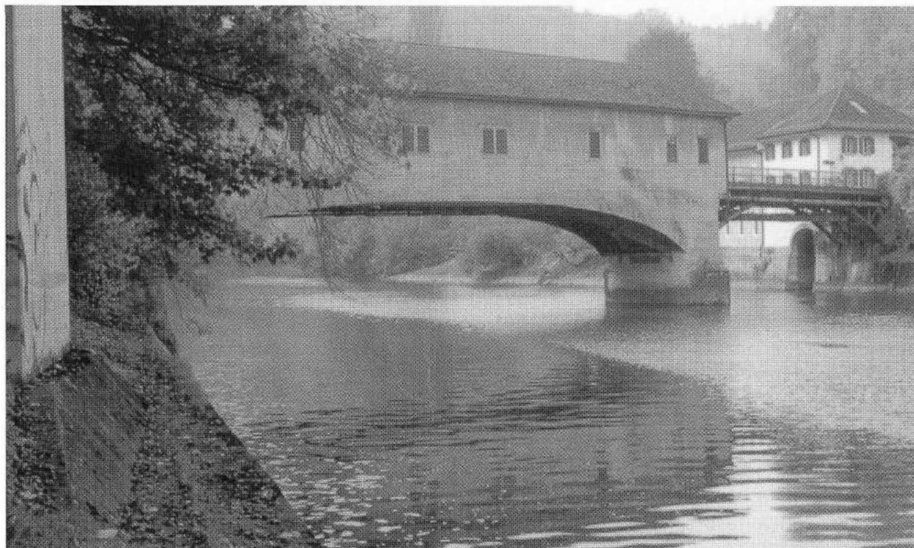
Die neue Holzbrücke von 1815 noch in mehr oder weniger dem damaligen Zustand; verlängert durch eine einfallslose Eisenkonstruktion.
