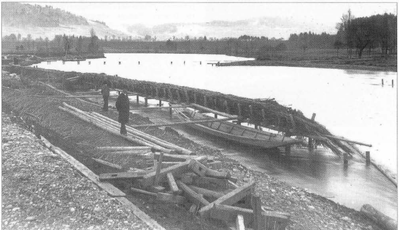
Auf Längshölzer, die die Pfahlreihe verbinden und festigen, sind Reisigbündel (Faschinen) gelegt und gebunden worden (bei Dietikon). Im Hintergrund ist eine Reihe von Pfählen quer über den Fluss zu erkennen: die Pfeiler für einen provisorischen Steg.
