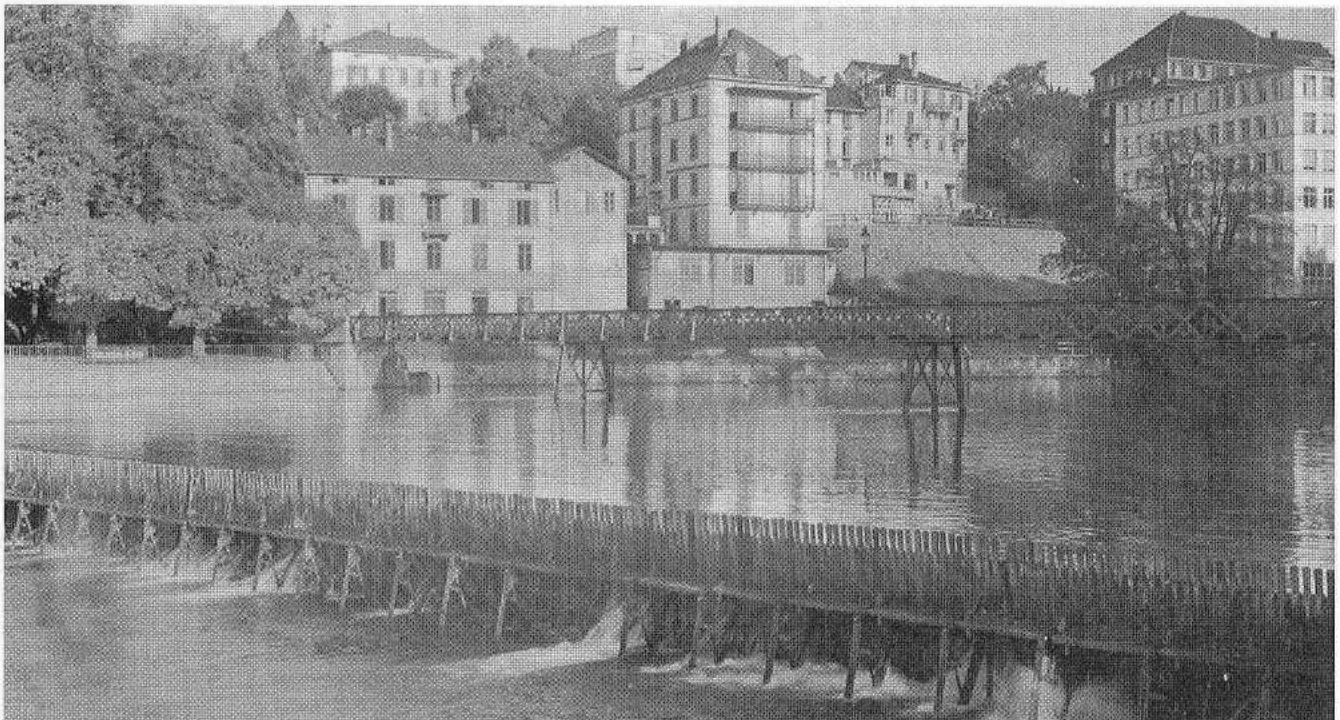
Das alte, hölzerne Nadelwehr (um 1875) am Platzspitz diente nicht der Regulierung des Seespiegels, sondern lenkte nur einen Teil des Limmatwassers in den Wasserwerkkanal zum Elektrizitätswerk «Letten». Letzteres ist noch immer in Betrieb und wurde kürzlich modernisiert.
