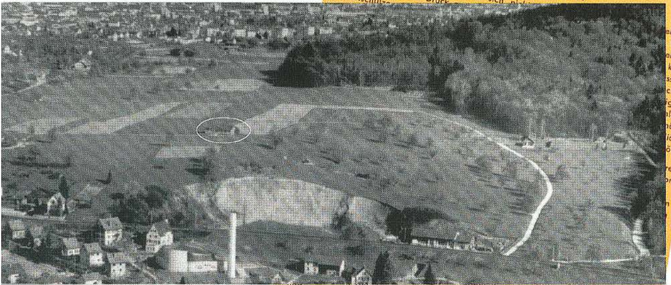
Blick von Westen über das «Plateau» des Schlierer Bergs, das die einen Gegner der Vorlage als Nah-Erholungsgebiet retten wollten, andere als künftiges Baugebiet betrachteten. In der Mitte des Bildes das alte Schützenhaus. Ganz oben im Bild hinter den Wiesen unmittelbar vor den ersten Häusern Altstettens der Schiessstand «Dunkelhölzli». Vorn die Wettertsche Kiesgrube.
