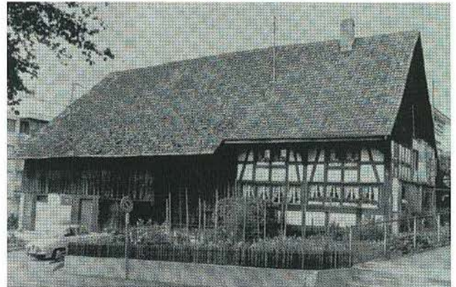
Der «Meierhof» (Haus «Gross»), Uitikonstrasse 27
