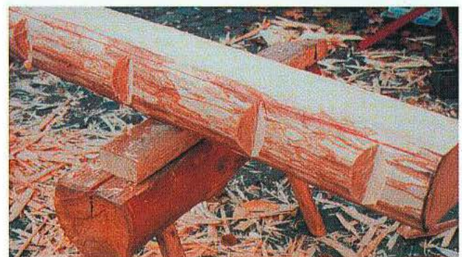
...wird aus einer Tanne ein Dachbalken.
