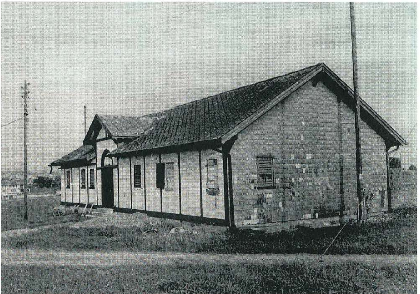
Das alte Schützenhaus 1967 als Freizeitzentrum – reif für den Abbruch!
