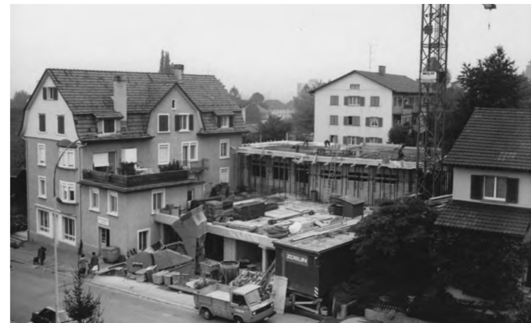
Bau und Möbelmüller entsteht an der Uitikonerstrasse.
