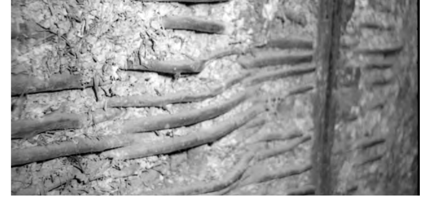
Kaminwand im „Stürmeierhuus“. Wände aus lehmverstrichenem Rutengeflecht waren noch im 17. Jahrhundert üblich.
