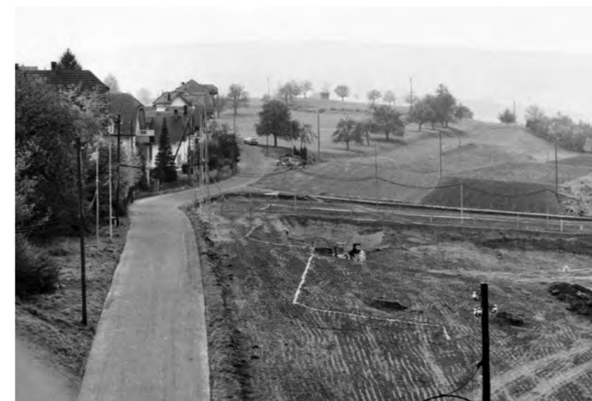
Aushub für das Migros-Hochhaus an der Kesslerstrasse. Rechts der Strasse das Steinlager der Gärtnerei Bolliger, im Hintergrund deren Baumschule.
