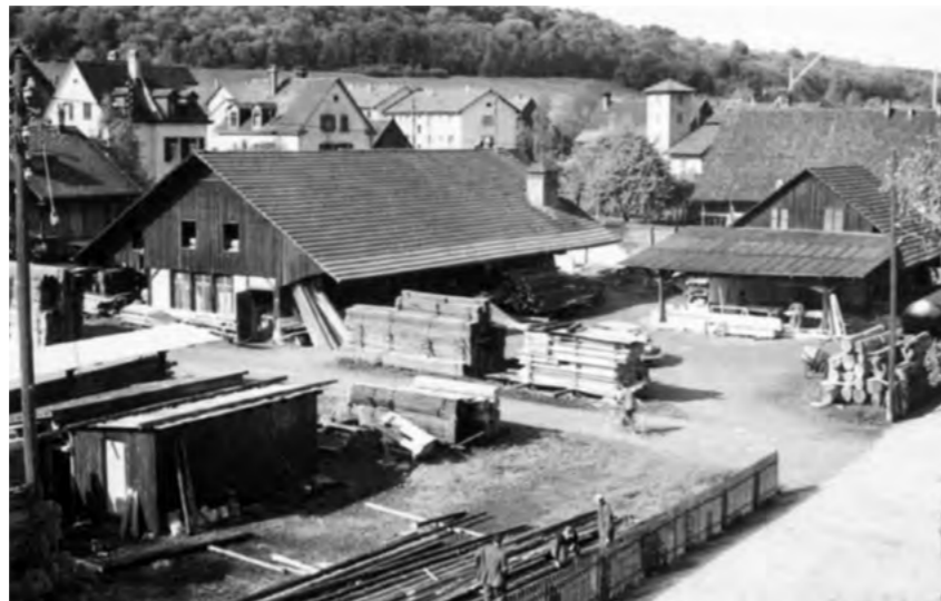
Der Werkplatz der Zimmerei Lemp, Ecke Uitikoner-/Schulstrasse 1955 – der Standort des „Salmen“.
