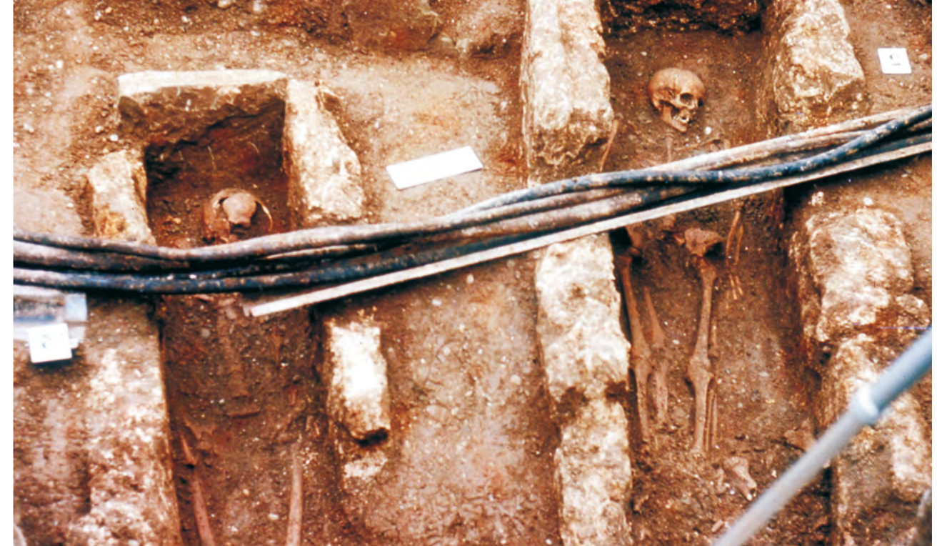
Alemannengräber: Beim Verlegen von neuen Telefonkabeln stiess man 1964 unter dem Vorplatz der ehemaligen «Lilie» auf zwei Alemannengräber aus dem 7. oder 8. Jh. Die Anordnung der Gräber sowie ihre Einfassung aus Tuffsteinblöcken weisen auf eine feste Begräbnisstätte einer bereits bestehenden Siedlung hin (828 erstmals schriftlich als «Sleiron» erwähnt). Die beiden Alemannen dürften somit die ältesten Schlieremer sein.
