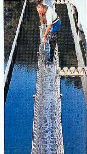
Die Mikroorganismen im Sand fällen die gelösten Stoffe aus dem Abwasser aus, die anschliessend zusammenklumpen.
