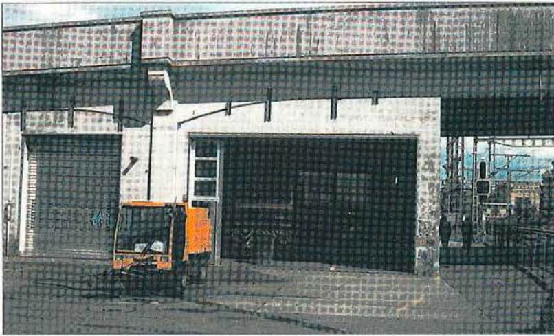
1954 bewilligte die Gemeindeversammlung einen Kredit von Fr. 19 000 für den Bau der Garage unter der Überführung der Engstringerstrasse.
