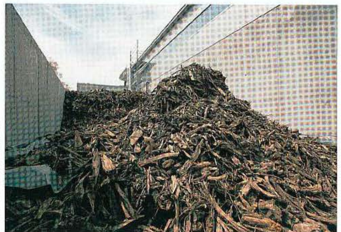
Aus diesem Haufen von Rinde und Wurzeln, dem Abluftfilter der Hallenentlüftung, bläst dem Besucher kein Fäulnisgeruch sondern der Duft nach Holz und Erde entgegen.
