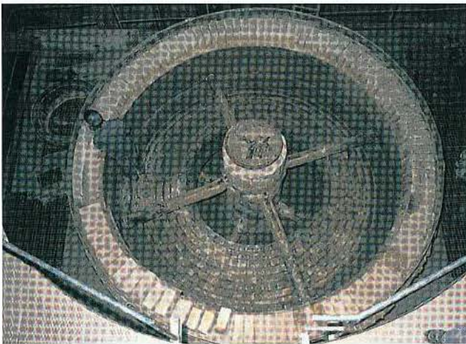
Blick von oben auf den Etagenofen während des Baus. Gut zu sehen: die hohle Zentralwelle mit den Krälarmen und der Etagenboden mit dem Durchlass in die untere Etage.
