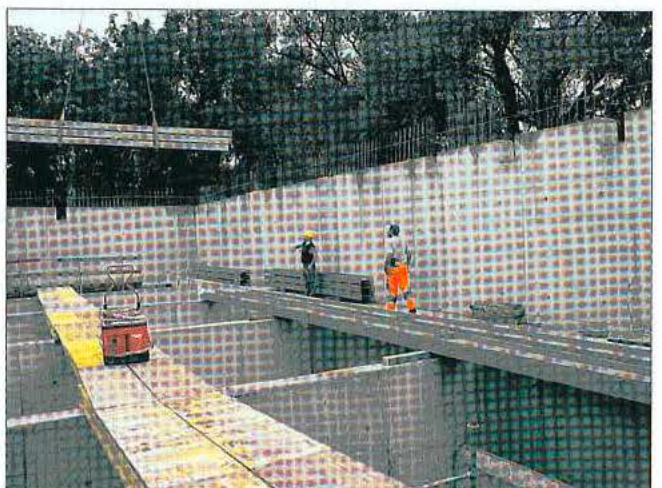
In der rechten, unteren Ecke des Bildes ist der abgerundete Rand eines Beckens zu sehen, über den das Wasser in die nächste Filteretage fliesst.
