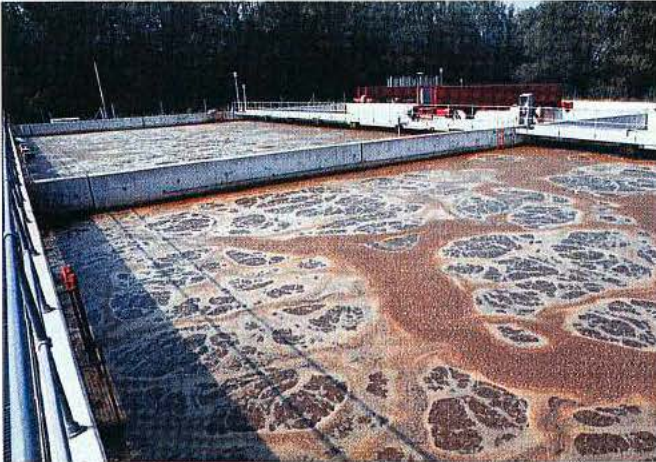
Das frühere Belebtschlammverfahren mit freischwebenden Mikroorganismen. Das Gemisch wurde belüftet und gerührt.
