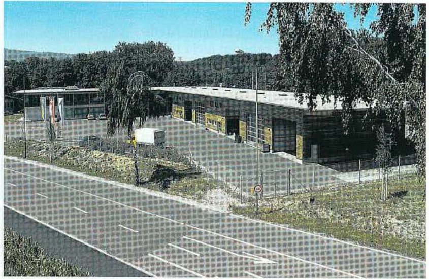
Der Werkhof. Am Anfang des Ostrakts (rechts) 2 Garagen des Abfuhrwesens, eine Werkstatt, der Baudienst und ganz hinten das Lager der Gas- und Wasserversorgung. Im Hintergrund der blau-graue Bürotrakt.
