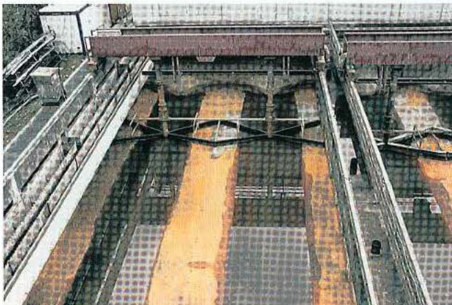
In den Nachklärbecken trennt sich der Belebtschlamm vom biologisch gereinigten Abwasser und wird abgesaugt.
