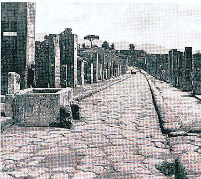
An die unterirdische Trinkwasserleitung waren vornehme Häuser und alle öffentlichen Brunnen angeschlossen. In die Strassengräben schüttete man auch Abfälle. Der Regen schwemmte sie dann in die Abwasserkanäle. Wasser aus den Brunnen- und Spültrögen floss ebenfalls dorthin.
