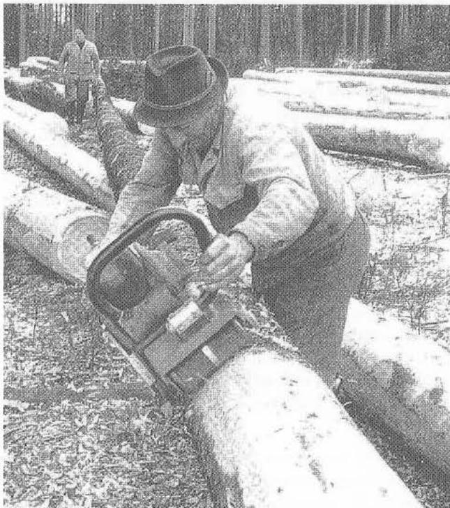
*Maschinelles Entrinden – Schnell gleitet die Maschine über den Stamm; aber die kleinste Fehlmanipulation kann böse Folgen für den Maschinisten haben.*
