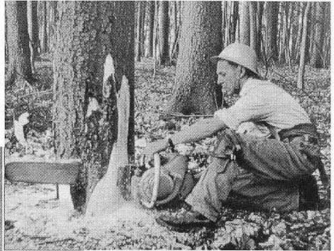
*Führung des Geräts und die richtige Körperstellung müssen beim Schroten mit der Kettensäge genau beachtet werden.*
