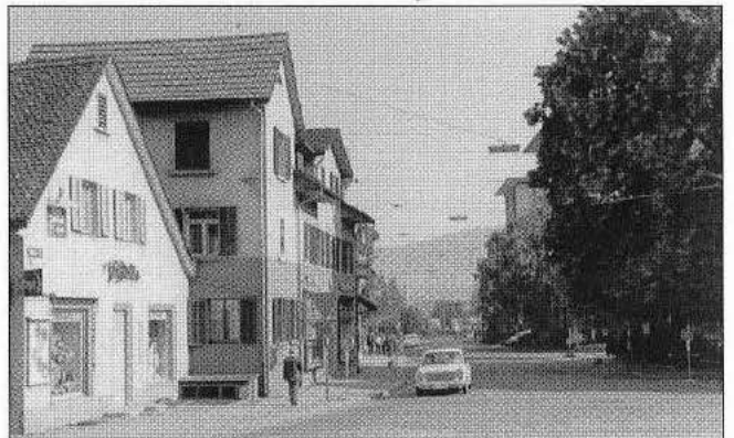
Das Haus Drogerie Brender an der Bahnhofstrasse. Abgebrochen für den Ausbau der Zürcher-/Badener- strasse. Haus Socher/Johner blieb.
