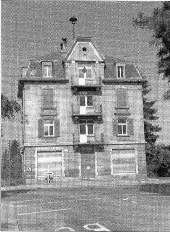
Das EKZ-Haus, ehemals Bahnhofstrasse 9. Sitz des Elektro-Ladens und des Ortsmonteurs der Elektrizitätswerke des Kantons Zürich (zwischen Standplatz Taxi-Stutz und Optikergeschäft Auer). Das Haus wurde abgerissen und heute befindet sich die Ringstrasse dort.
