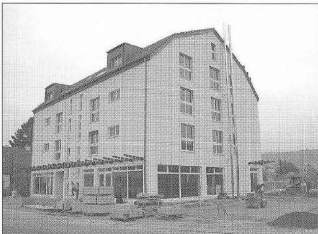
Die neue Liegenschaft an der Engstringerstrasse 10 wurde im November 2004 fertiggestellt. Ladengeschäfte im Parterre und Mietwohnungen stehen seither zur Verfügung.
