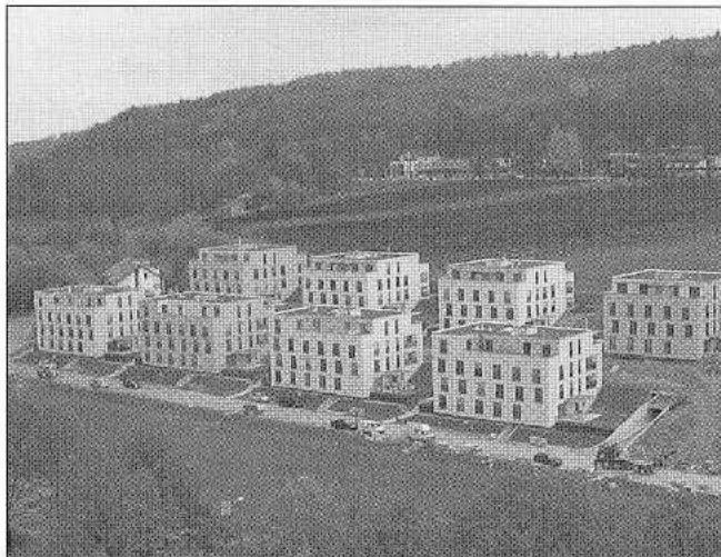
Hohfurren-Überbauung – Im Hintergrund der SBB-Bahnhof Urdorf
