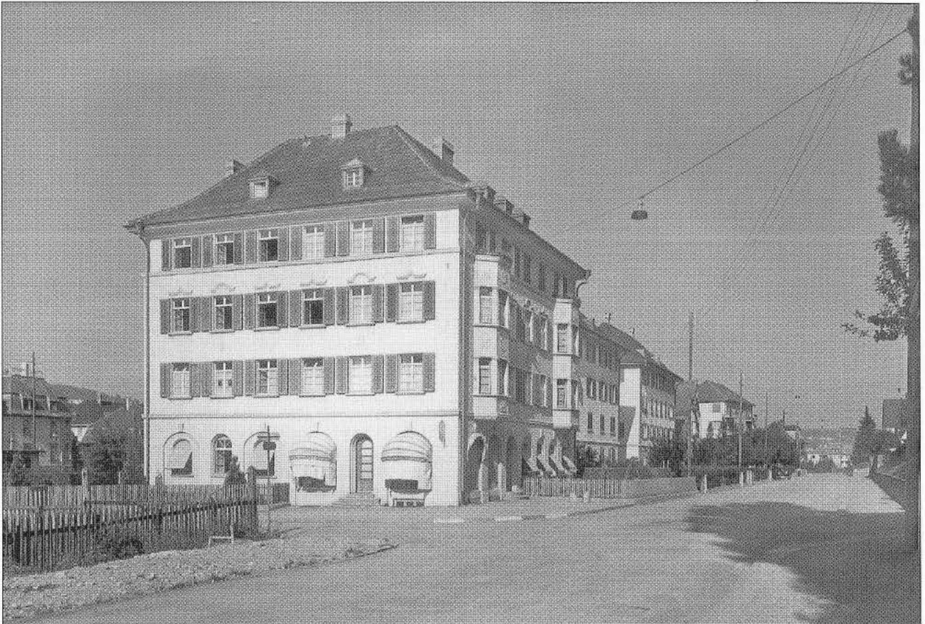
Ehemalige Bäckerei-Konditorei Epple, Schulstrasse 13; Aufnahme aus dem Jahr 1937
