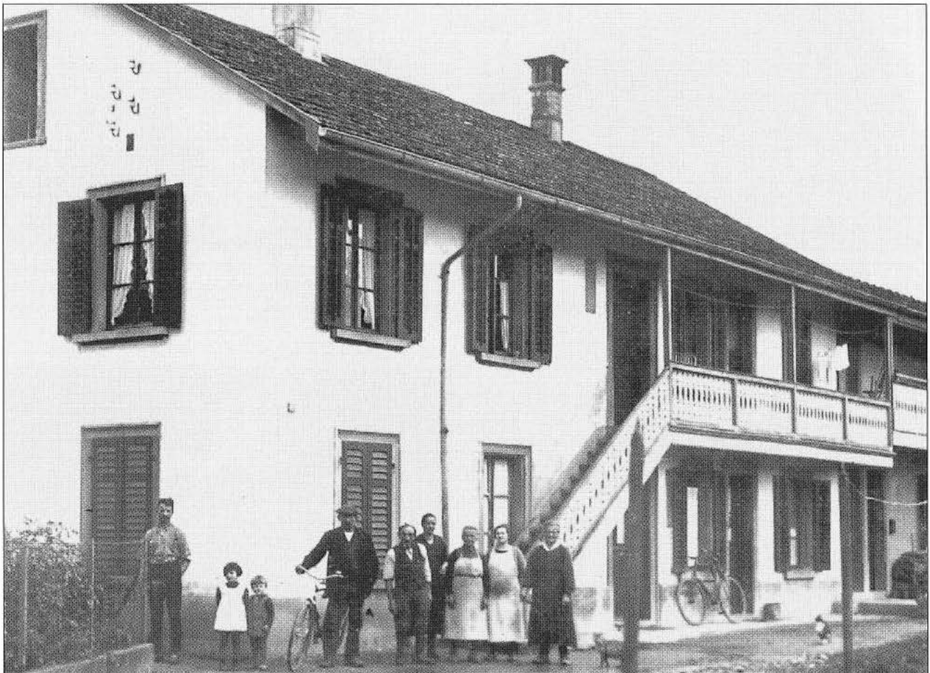
Haus Tschäppätt. Dahinter wurde die erste Hühnerfarm im Dorf betrieben, welche diesen Namen verdiente. Im Jahr 1954 eröffnete an dieser Stelle (Engstringerstrasse 43) Hartmann Reutlinger (Autotransporte) seine Firma mit Druckfässern zur Klärgrubenentleerung. Vor dem Einbau der obligatorischen Schwemmkanalisation rentierte der Betrieb vorzüglich. Im Haus Engstringerstrasse 41 wohnte auch die Familie Ramseier.
