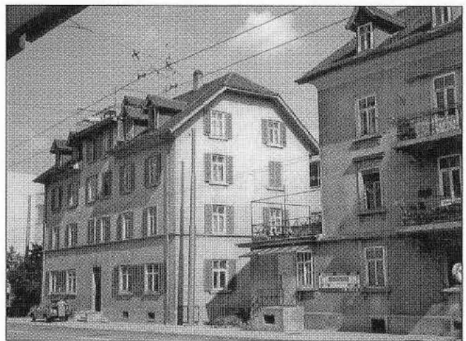
Zürcherstrasse: Sonnenhof und Josefsheim – beim Abbruch, zirka 1970
