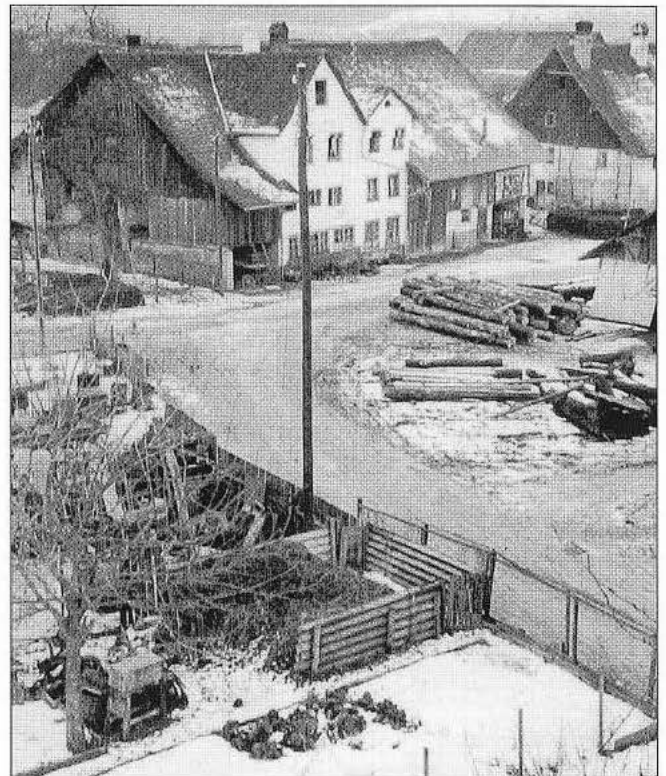
Das Alteisenlager von Heinrich Furrer (links) an der Sägestrass. Aufnahme aus den Dreissigerjahren.
