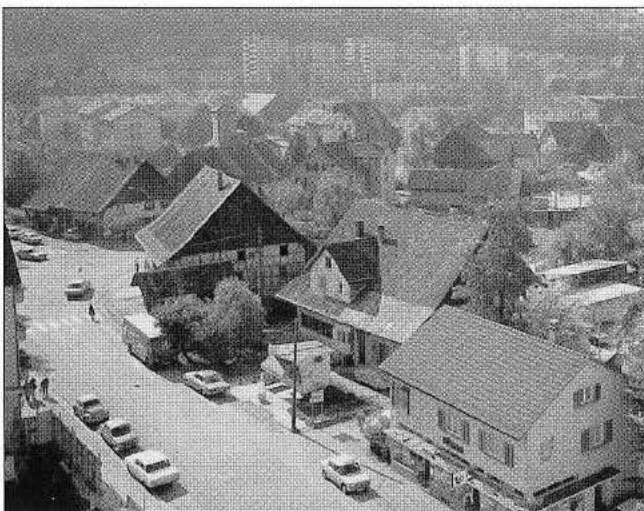
Blick auf die Uitikonerstrasse und die Salmen-Kreuzung. Im neueren Haus war die Drogerie A. Huber und das Lederwarengeschäft von Jos. Styger untergebracht. Links davon die «Menschenfabrik» und weiter oben das Bauernhaus von Weibel Lips.
