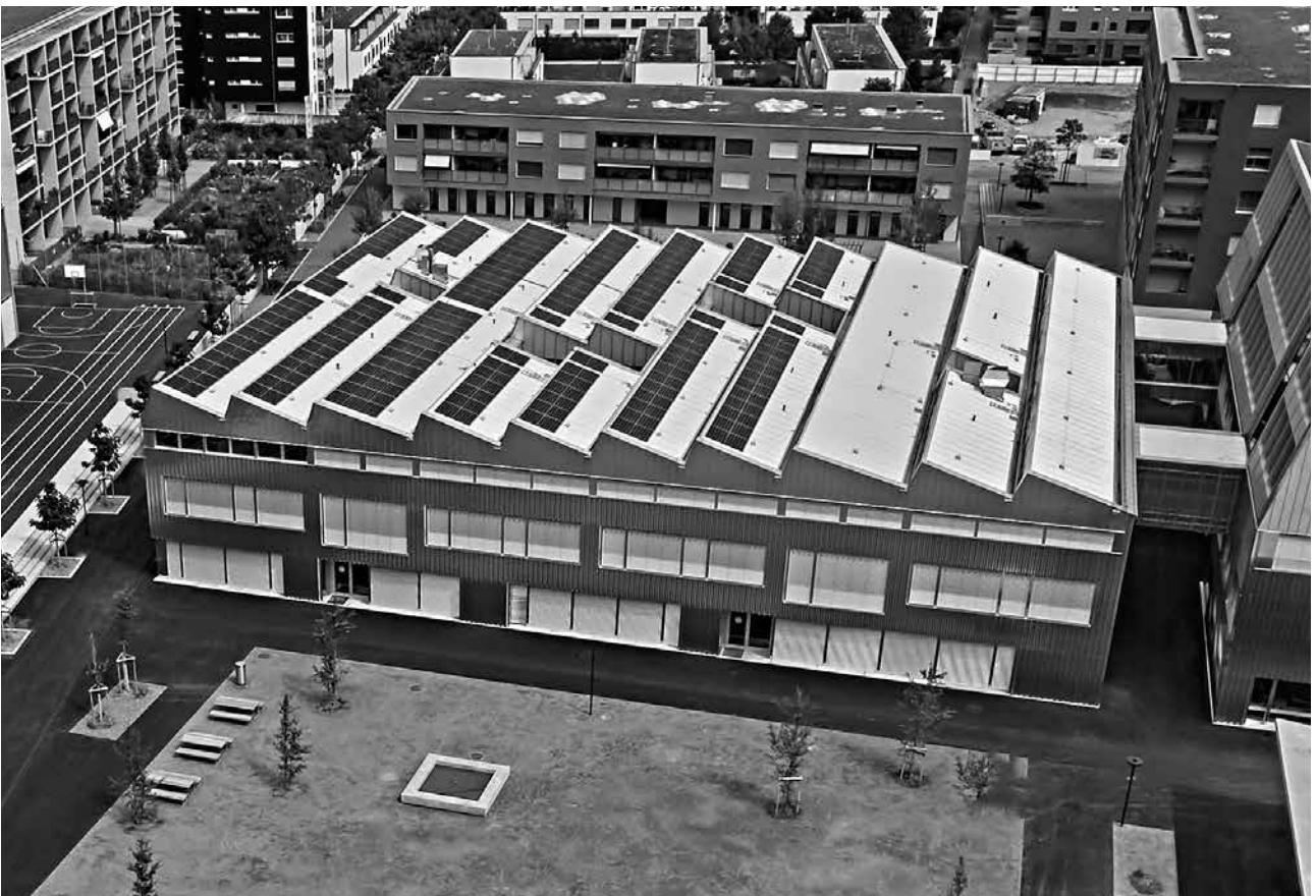
Die Photovoltaikanlage liefert mit zirka 500 Panels auf 8'000 m 2 rund 135'000 kwh pro Jahr.
