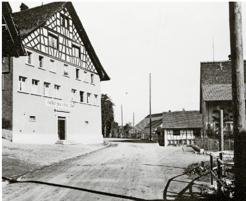
Die Zürichstrasse vor dem Gasthaus Zum Wilden Mann während Vorbereitungsarbeiten für eine allgemeine Strassensanierung durch das Tiefbauamt Zürich im September 1934. Kurz zuvor hatte Walter Hafner den Gasthof übernommen.
