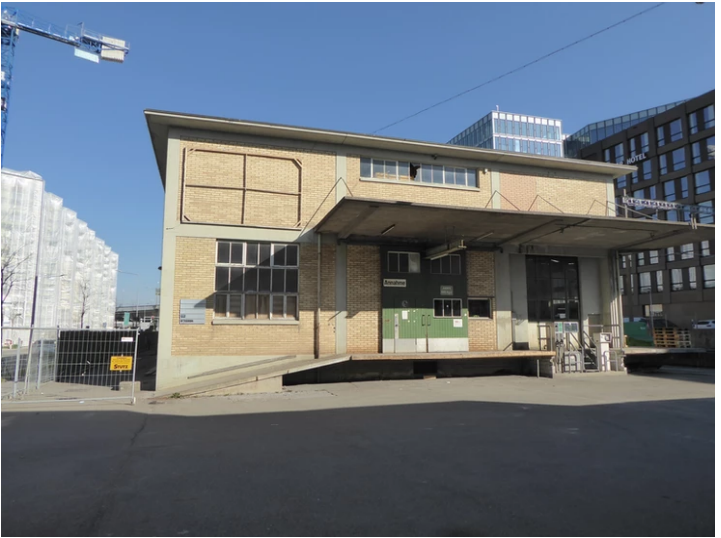
Erhaltenswürdig: Industriebaute Manegg 2022. Foto SB (4.3.2020).
