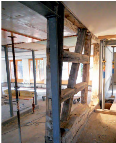
Provisorische und alte Stützen des Gebäudes
