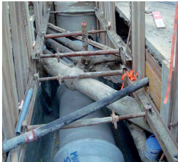
Katzensteigbach: Behinderungen durch bestehende Werkleitungen
