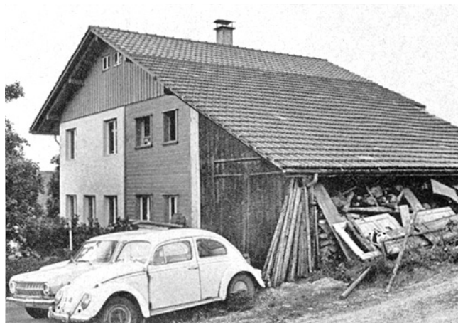
Wila. Manzenhub. Haus Manz, Vers.-Nr. 41. Neubau von 1969/70.
