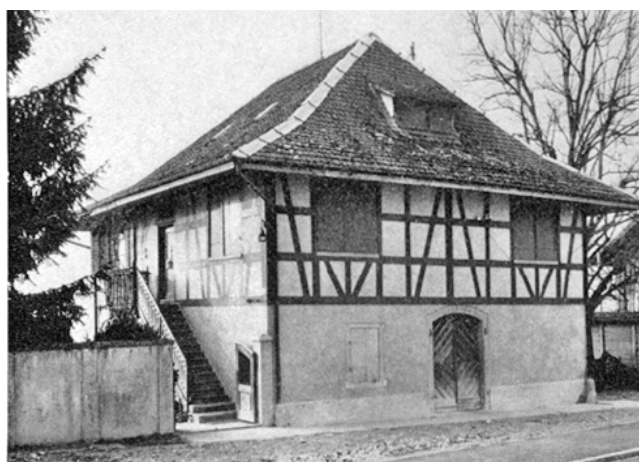
Oberengstringen. Kirchweg 5. «Hessengut»-Pächterhaus, abgebrochen 1970.
