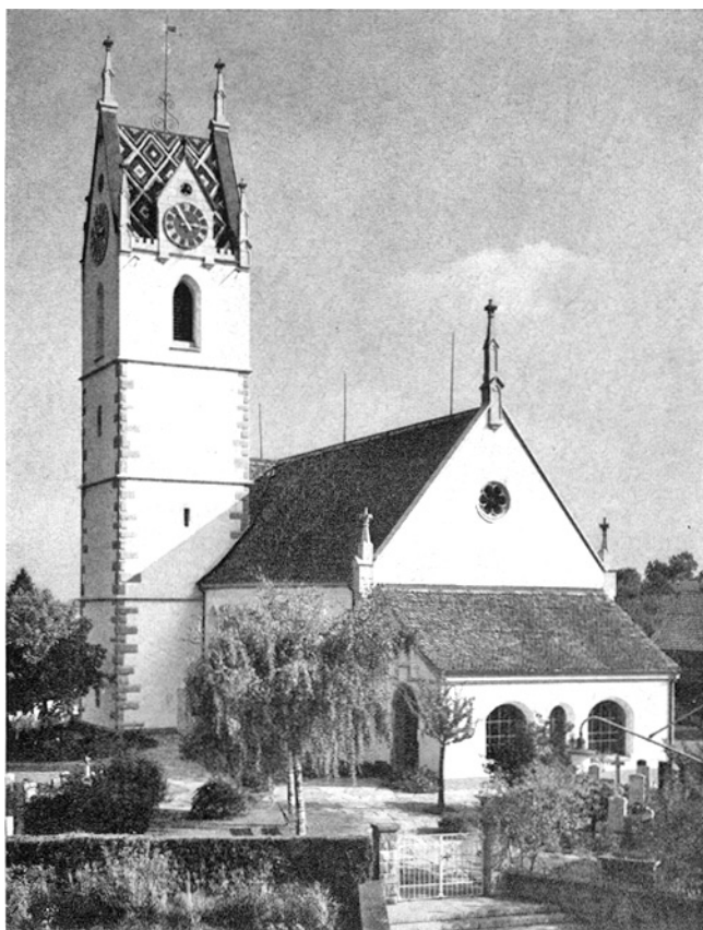
Maur. Reformierte Kirche. Äusseres nach der Renovation 1969/70.
