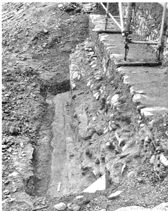
Bülach. Reformierte Kirche. Vorfundamente für die Westmauer von 1678.
