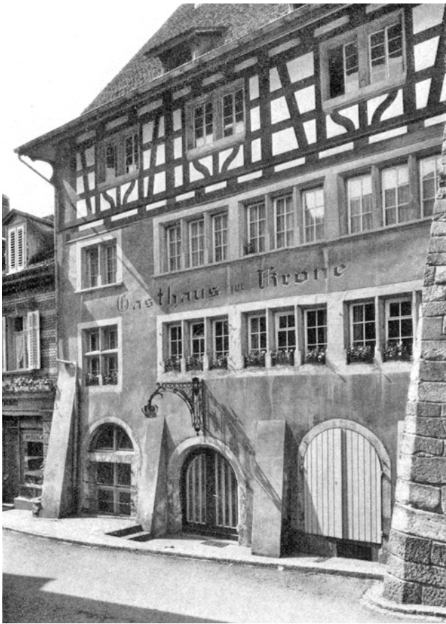
Eglisau. Untergrasse. Gasthof «Zur Krone». Hauptfassade vor der Renovation 1969.
