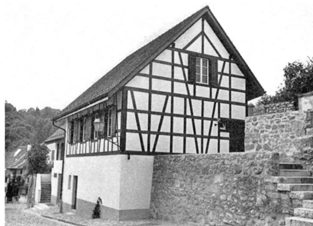
Regensburg. Unterburg. Neubau 1968/69 an Stelle des Riegelhäuschens Vers.-Nr. 53.
