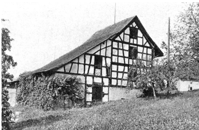
Oberweningen. Chileweg. Speicher Vers.-Nr. 136.
