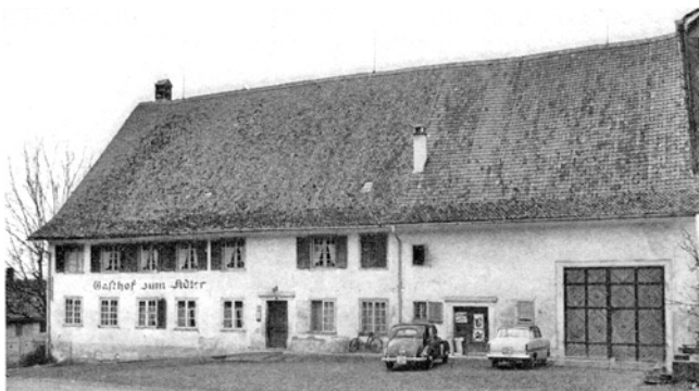
Rorbas. Gasthaus «Zum Adler». Vor der Renovation 1966.
