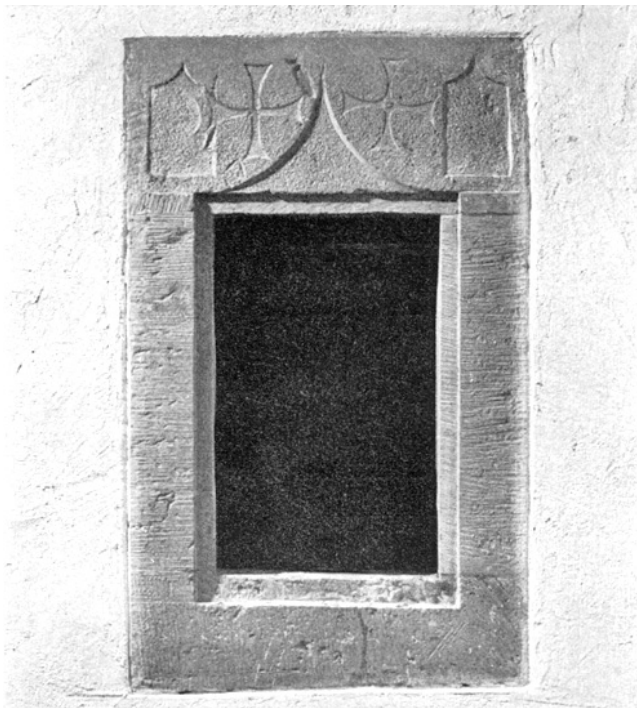
Wangen. Reformierte Kirche. Ehemaliger Turmchor. Spätgotische Sakramentsnische.
