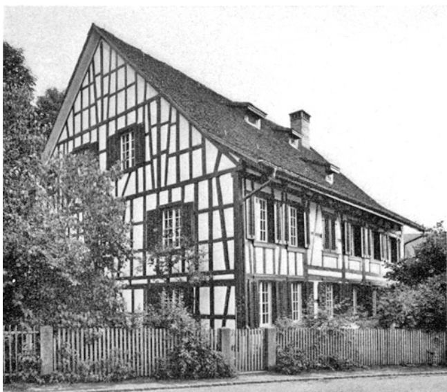
Maschwanden. Pfarrhaus. Nach der Renovation 1968/69.
