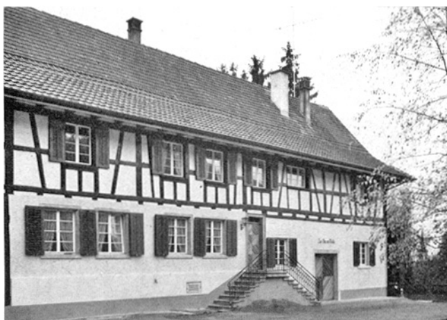
Rafz. Obere Mühle. Nach der Renovation 1969.
