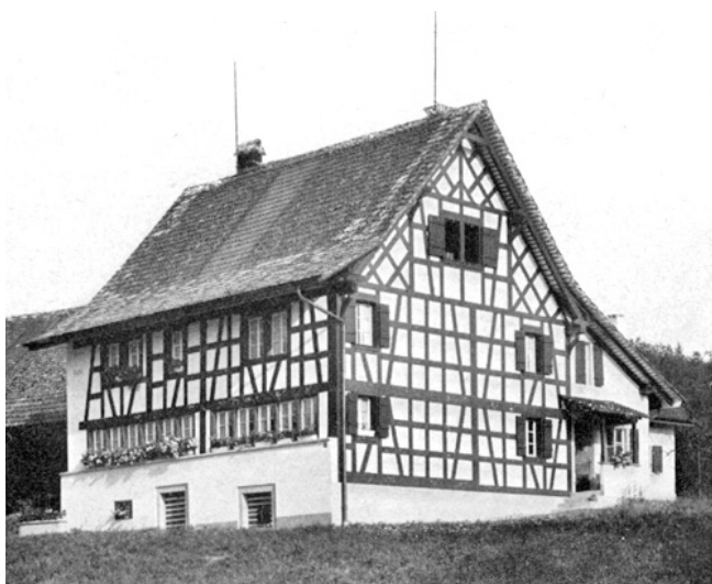
Bubikon. Talhof. Bauernwohnhaus Vers.-Nr. 567. Nach der Renovation.
