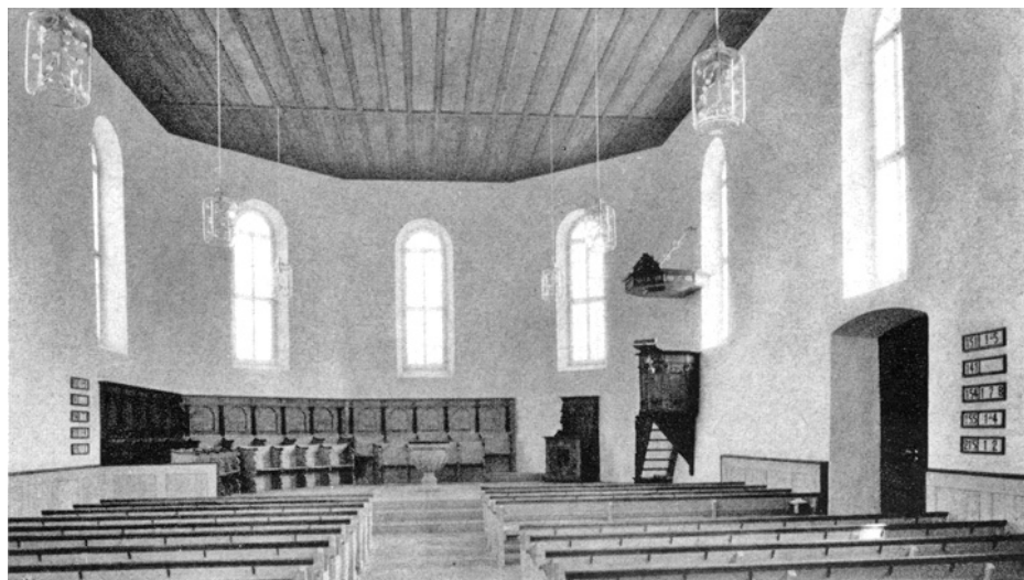
Weiach. Reformierte Kirche. Inneres nach der Restaurierung 1967/68.
