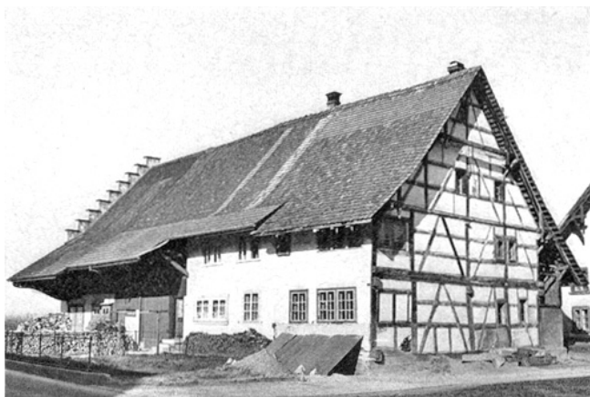
Flaach. Oberhof. Hausteil Vers.-Nr. 468 vor der Renovation.
