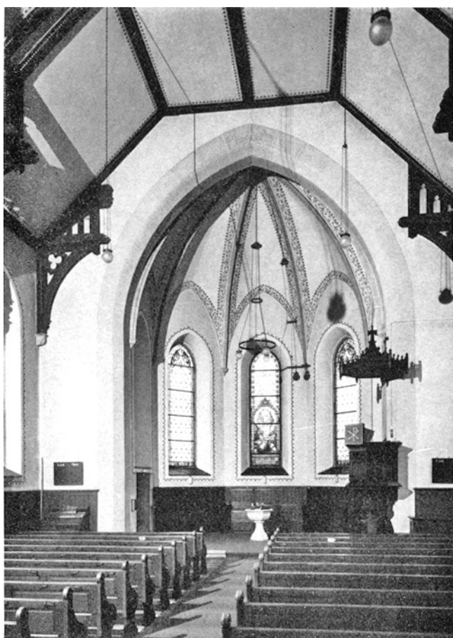
Lindau. Reformierte Kirche. Inneres vor der Restaurierung 1967/68.
