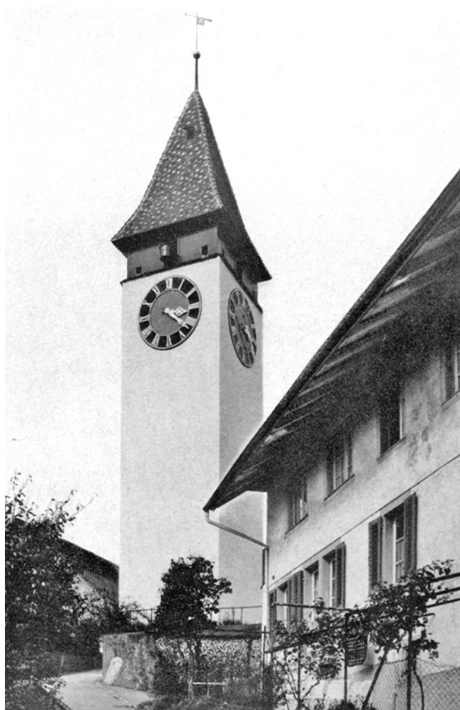
Opfikon. Zeitturm. Nach der Restaurierung 1968.
