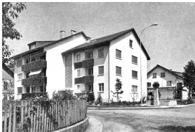
Elgg, Untergrasse/Ecke Hintergasse. Neubau anstelle des Hauses «Zur Blume». 1969/70.
