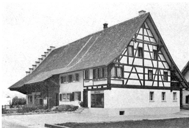
Flaach. Oberhof. Hausteil Vers.-Nr. 468 nach der Renovation 1967/68.
