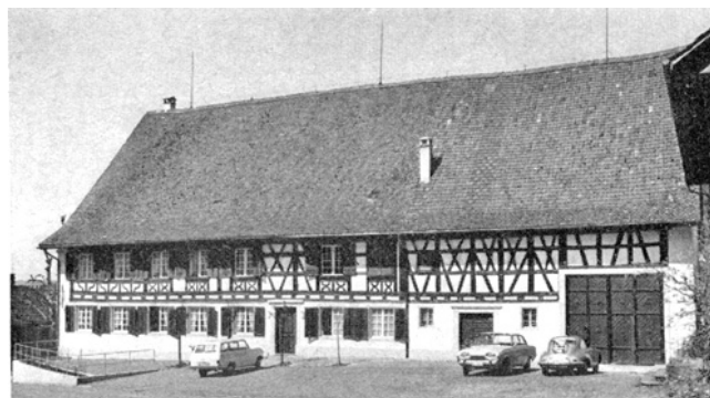
Rorbas. Gasthaus «Zum Adler». Nach der Renovation 1966.
