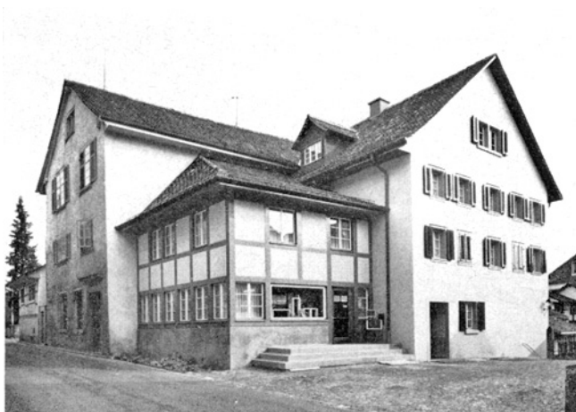
Grüningen. Haus Vers.-Nr. 869 (Färberhaus). Neubau von 1968/69.
