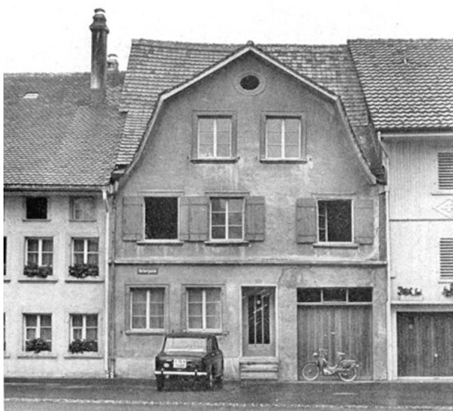
Elgg, Hintergasse. Ehemaliges Bauernhaus Vers.-Nr. 249. Vor (oben) und nach (unten) dem Umbau von 1970.
