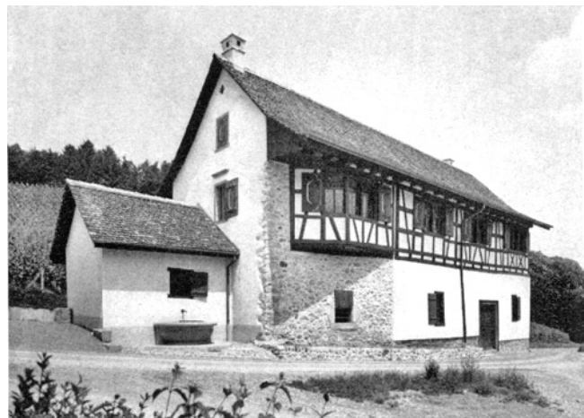
Neftenbach. Stadt-Trotte Winterthur. Nach der Restaurierung 1969/70.
