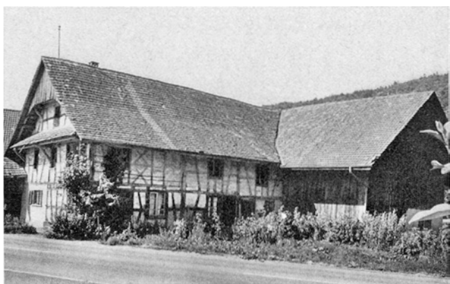
Niederweningen. Ehemaliges Bauernhaus Vers.-Nr. 31, abgebrochen 1971.
