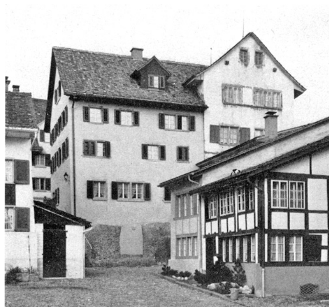
Grüningen. Haus Vers.-Nr. 843 (Mangihaus). Neubau von 1969/70.
