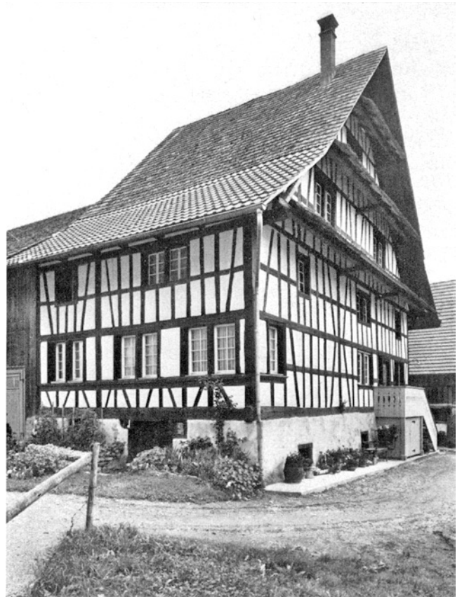
Rifferswil. Oberripperswil. Bauernhaus Vers.-Nr. 33. Nach der Renovation 1971/72.
