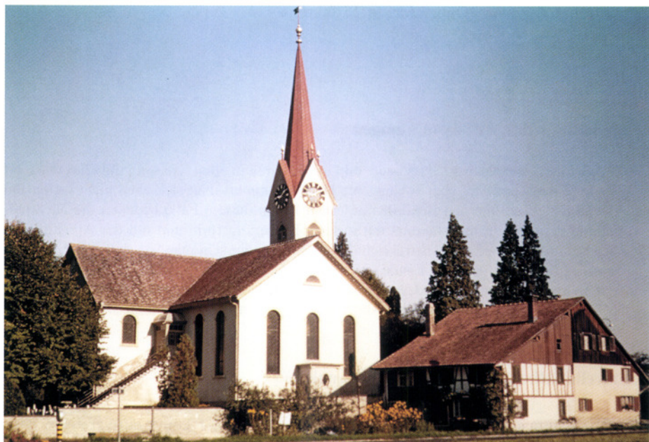
Der letzte Gottesdienst in der alten reformierten Kirche im Wil wurde am Pfingstmontag, den 3. Juni 1968, abgehalten. In den folgenden Tagen hoben Spezialisten den Turmhelm und den Glockenstuhl ab und transportierten diesen mit den vier Glocken zum Kirchgemeindehaus.
