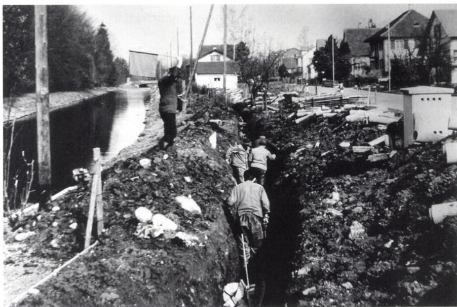
Leitungsbau an der Hermikonstrasse auf der Höhe der Claridenstrasse: Die Arbeiter ziehen die Stromkabel mit Seilen in die vorbereiteten Röhren ein. Der Arbeiter mit der Fahne gibt die entsprechenden Kommandos.
