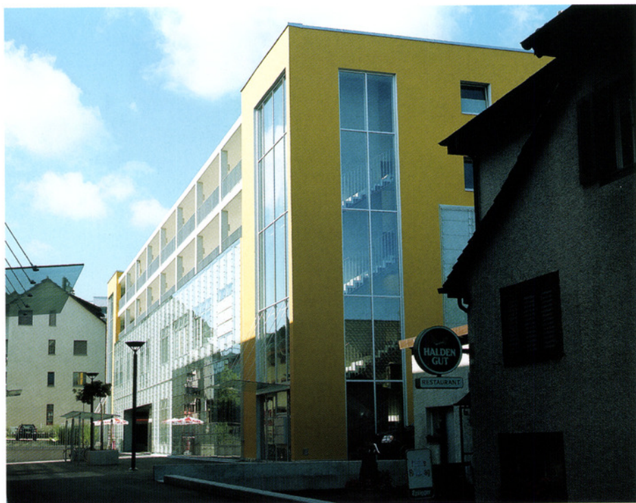
Die beiden Baukörper formen eine Einkaufsstrasse und eine Wohngasse. Die direkte Umgebung widerspiegelt sich im Glas. Die farbigen Fassaden setzen willkommene Farbtupfer.
