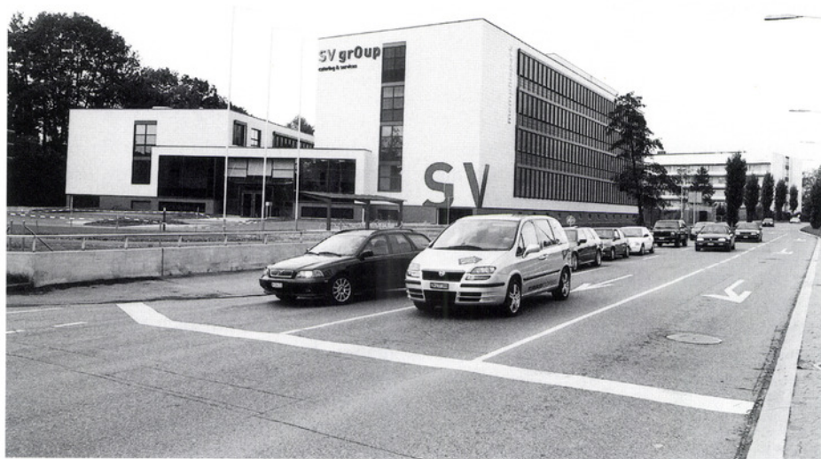
Im neuen Geschäftshaus «Memphispark» arbeiten seit Oktober 2004 200 Mitarbeiter der SV Group.
