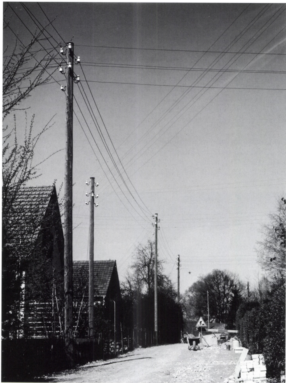
Freileitungen prägten das Dübendorfer Ortsbild zu Beginn der Geschichte der Glattwerk AG bis weit in die Sechzigerjahre. Die Montage, die Netzerweiterungen und die Umbauten waren arbeitsintensiv.
