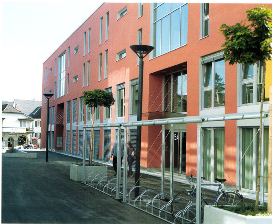
Im Frühjahr wurde die moderne Zentrumsüberbauung «Inside» der Helvetia-Patria-Versicherungen fertiggestellt. Architekt Urs Nüesch's Gebäude in städtisch-urbanen Bauformen prägen Dübendorfs Zentrum nachhaltig.
