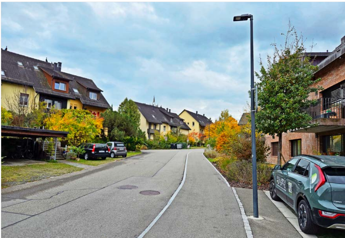
Eine «intelligente» Leuchte an der Unterdorfstrasse in Maur.
