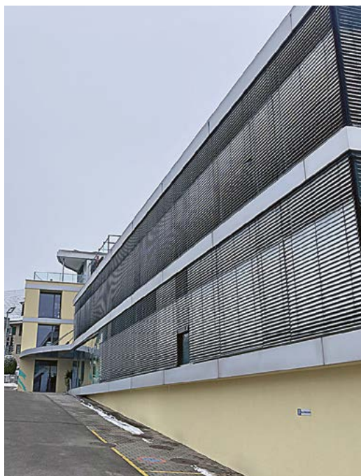
Im GGA-Haus weht bald ein frischer Wind. Bild: TRE
