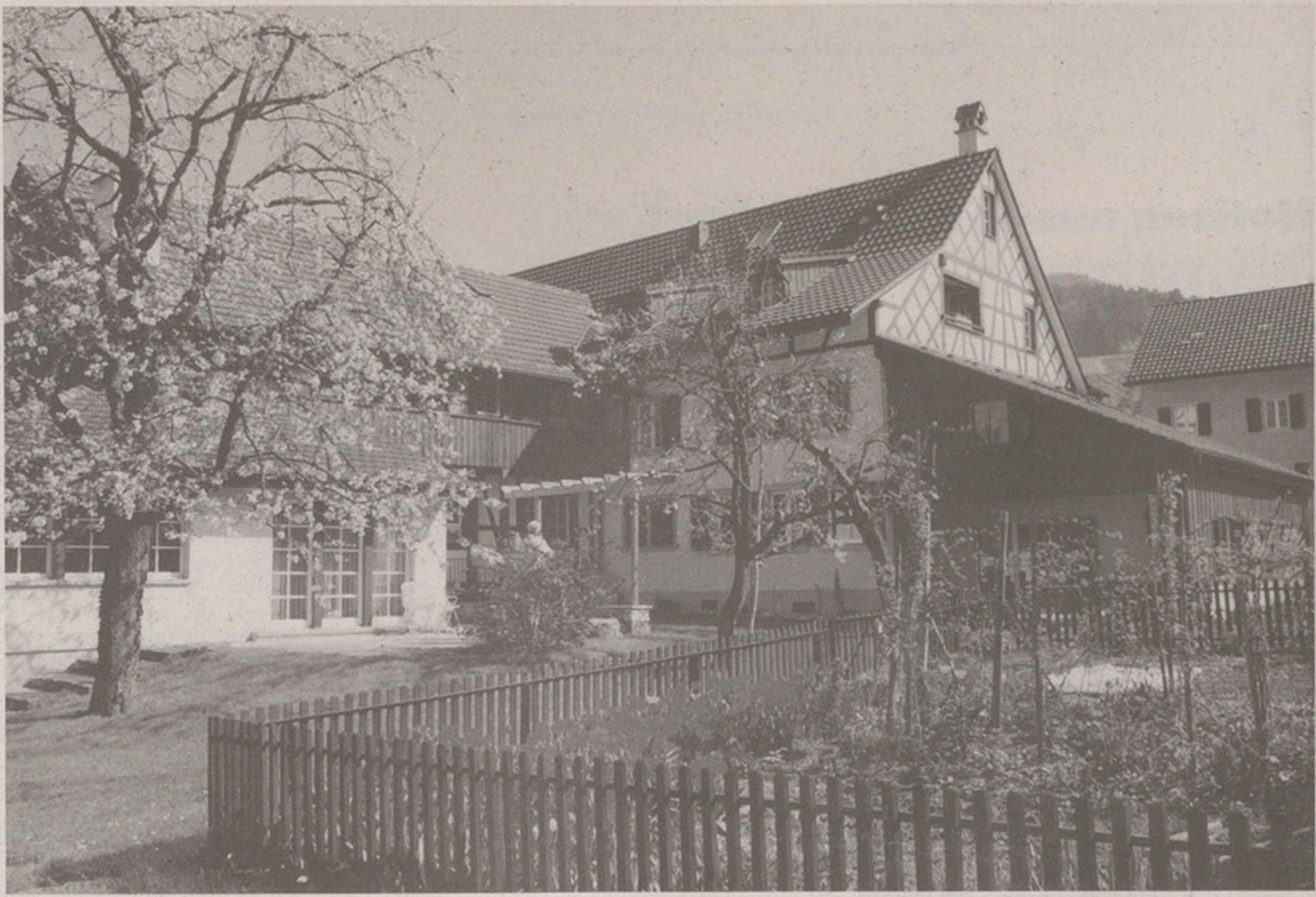
Wohlgeunger Umbau einer Scheune in ein Wohnhaus im Zürcher Weinland. Solche Herausforderungen, wo es gilt alte Bausubstanz (nach Möglichkeit) zu erhalten und Modernes – zeitgemässe Wohnkultur, Komfort, Ansprüche – zu integrieren, das schätzt das Architektenteam von Urs Weidmann.
