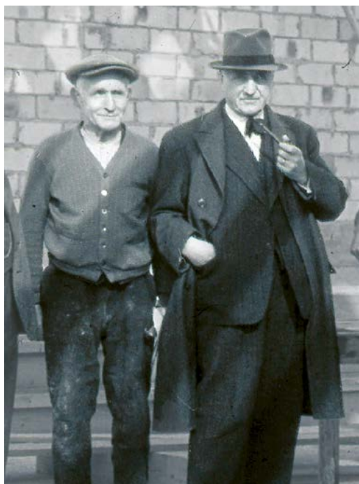
Bauinitiator Julius Wettstein und Architekt Heinrich Müller, hier noch beim Bau des Pünt-Schulhauses 1942. Bild: Archiv Ortsgeschichte
