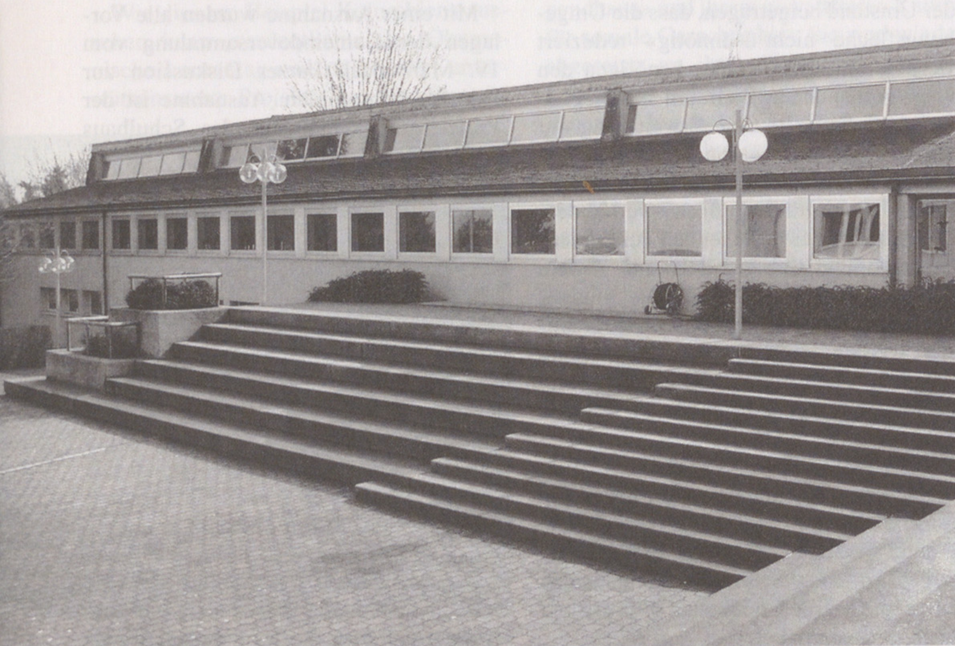
Die Schulanlage Aesch auf der Forch soll saniert werden. Der älteste Teil stammt aus dem Jahre 1959 und beinhaltet Schule und angrenzend den Kindergarten. (Foto: lii)
