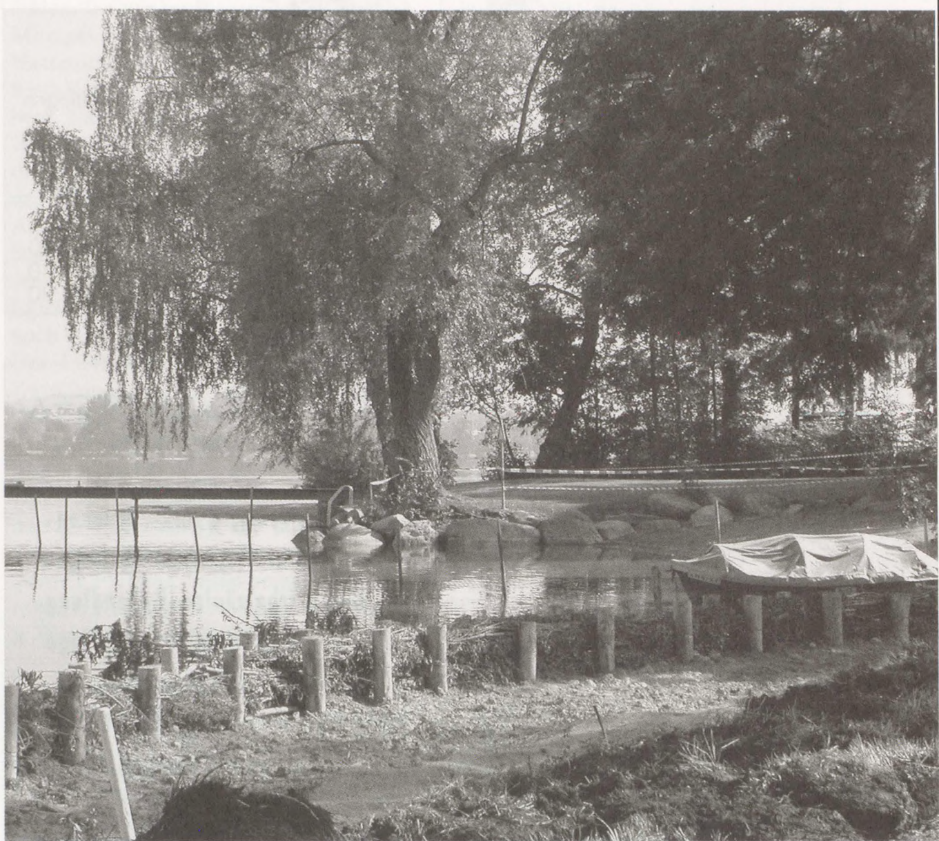
In der Badi Maur wird das Ufer teilweise mittels Pfählen und dazwischen verschienten Weidenrollen neu befestigt. (Foto: kim)
