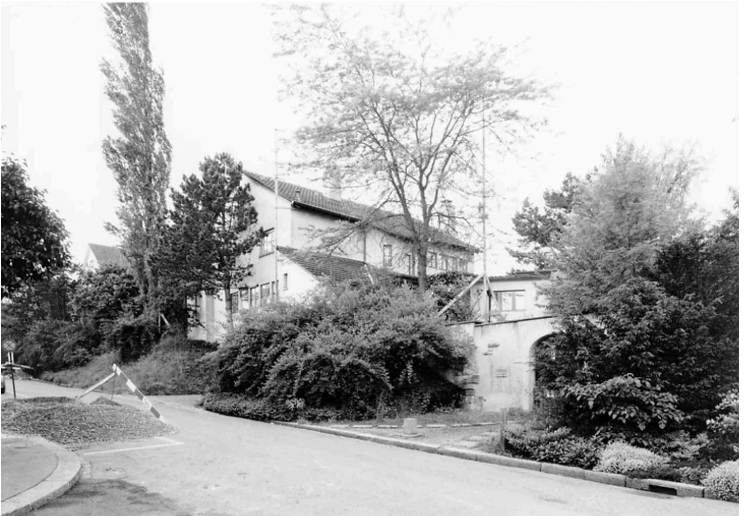
Frohaldstrasse 48. Eigenheim von Dr. med. Max Edwin Bircher-Müller. Baujahr 1933. Aufnahme 1980. Baugeschichtliches Archiv Zürich.
