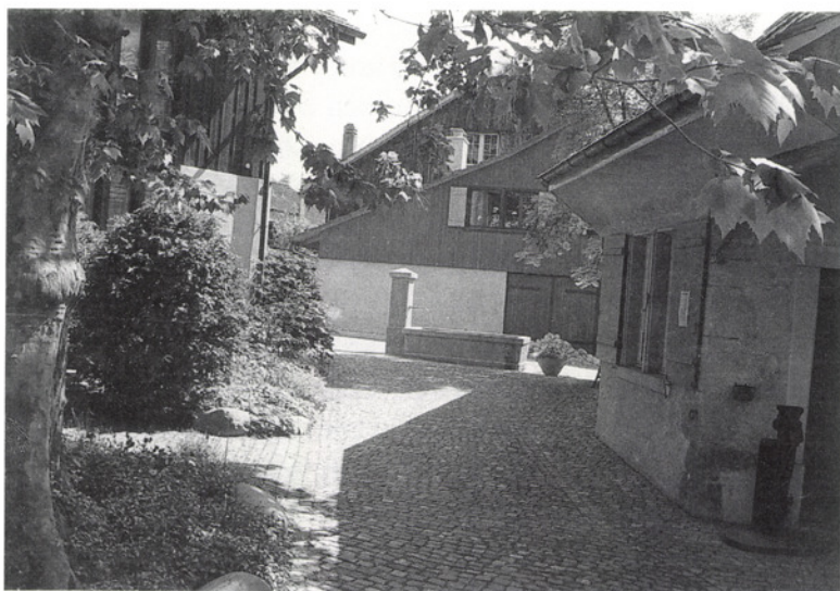
Eingangspartie zum Burghof mit dem Burgbrunnen. Auf unserem Bild ist noch der alte Trog mit der Jahreszahl 1832 zu sehen (ersetzt im Jahre 1990) Foto Uschi Meister
