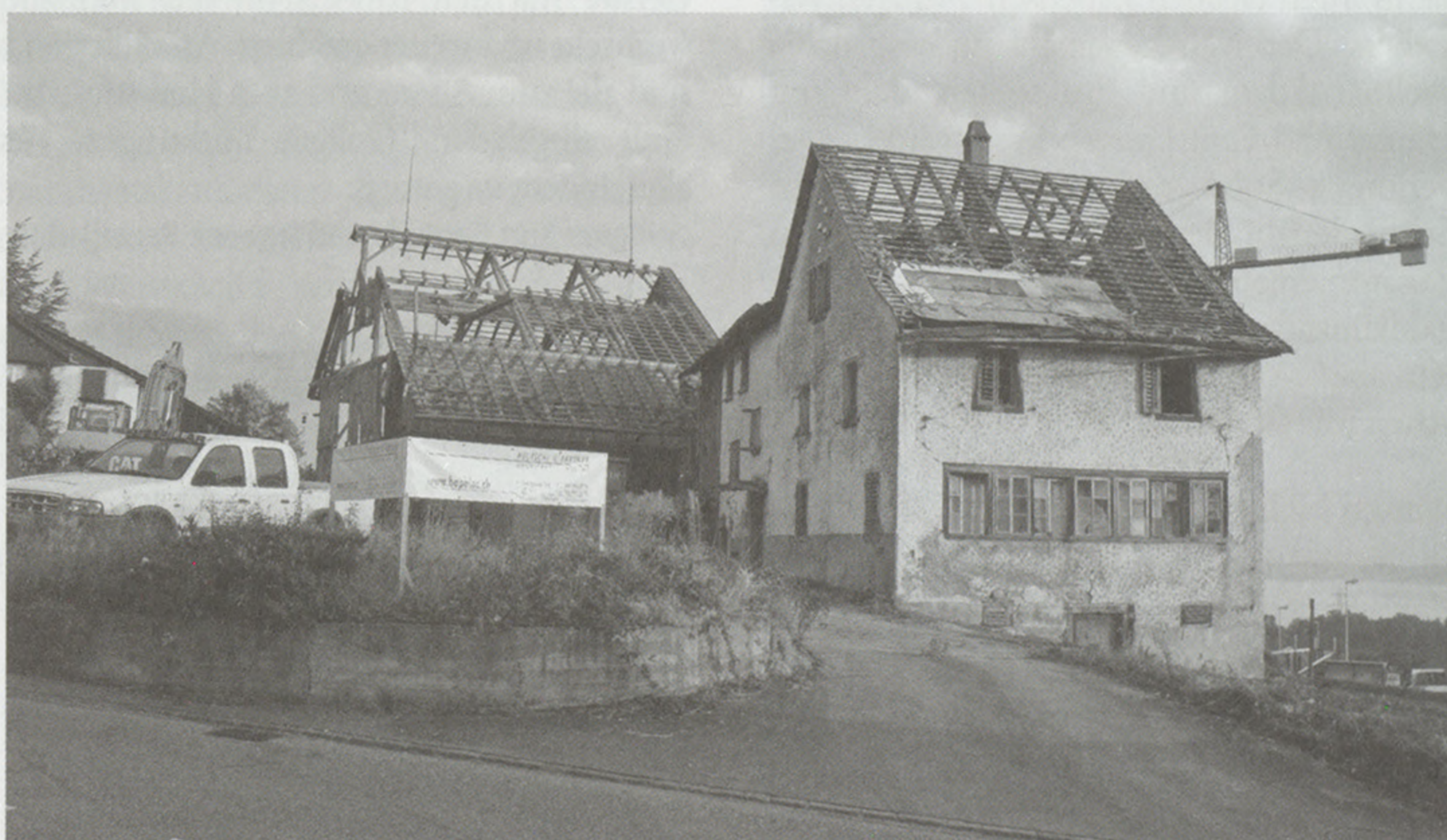
Der «Schandfleck» von Binz – das seit über 12 Jahren leer stehende und zerfallende Haus samt Stall wurde im Laufe der letzten Woche abgerissen. Anstelle des alten Gebäudes wird neu ein Geschäftshaus gebaut und auf der Wiese dahinter entstehen zwei Einfamilienhäuser. (Foto: sl)
