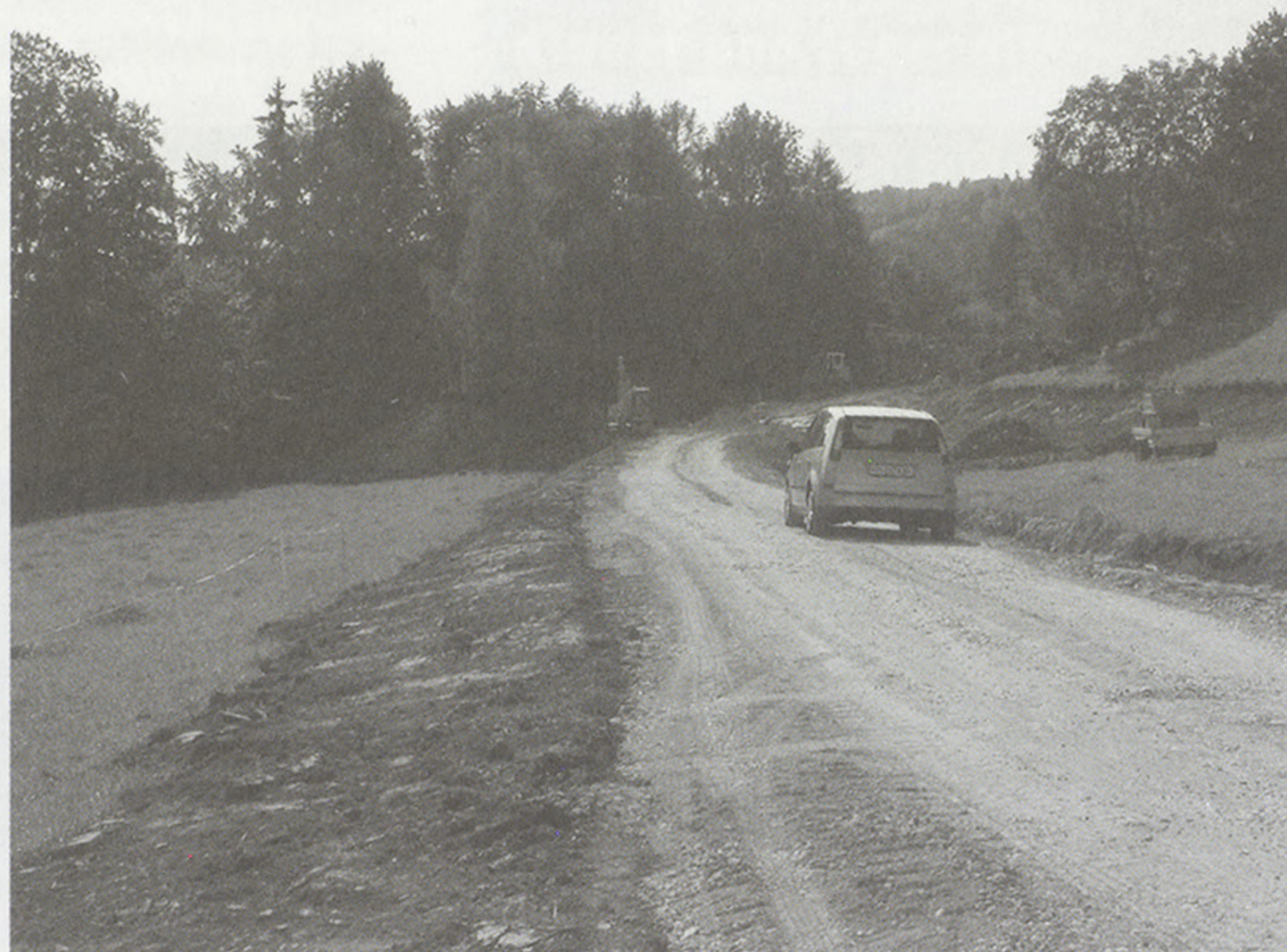
Baupiste ab der Hellstrasse für die Baustellenerschliessung der Überbauung an der Berghaldenstrasse. (Fotos: zvg)
