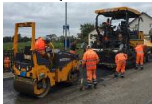
In Winterberg mussten Wasserleitungen erneuert werden.
