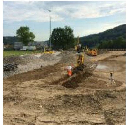
Grossbaustelle auf dem Sportplatz Grafstal
