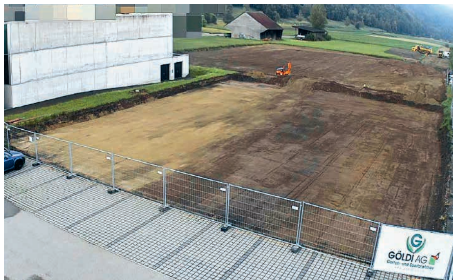
Baustelle nach den Erdarbeiten Ende Juni
