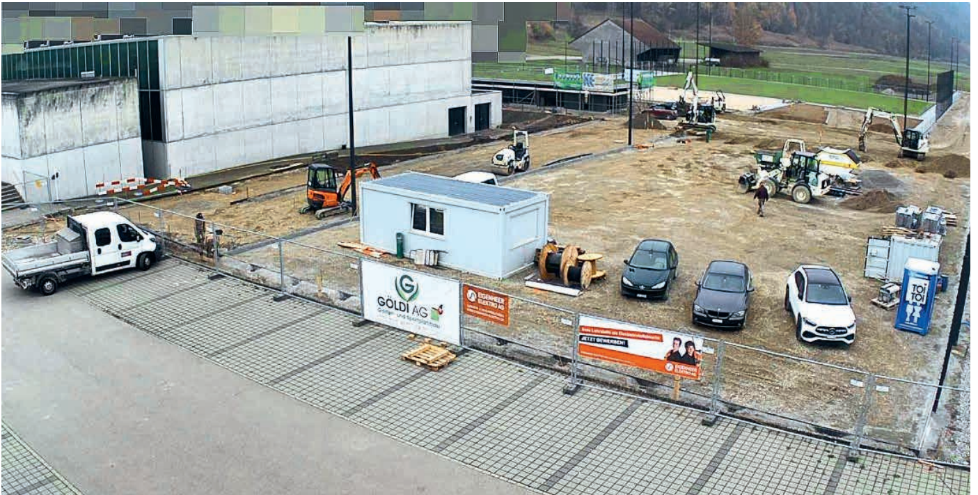
Baustelle Anfang November
