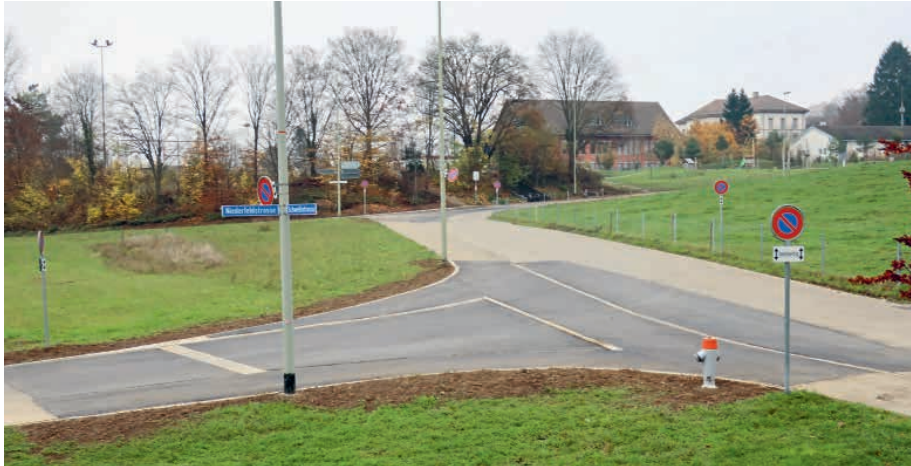
Trottoirüberfahrt bei der Sporthalle
