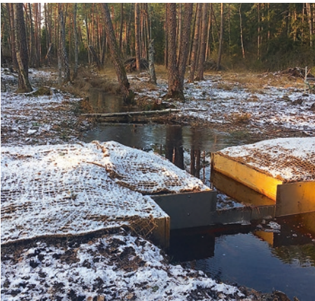
Abb. 11: Stauanlage mit verstellbarem Wehr im Torfried. (Foto M. Graf)
