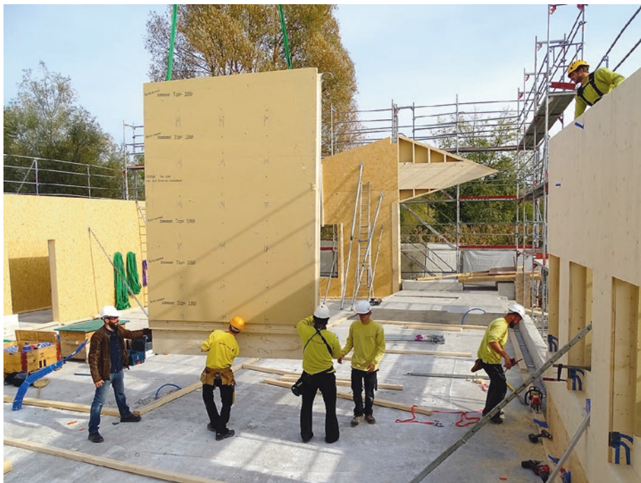
Abb. 20: Ende Oktober werden die rund 80 vorgefertigten Bauteile aus einheimischen Hölzern auf dem tiefverankerten Fundament präzise zusammengefügt und das ganze Haus inkl. dem Dach in rund vier Tagen aufgebaut. (Foto E. Ott)
