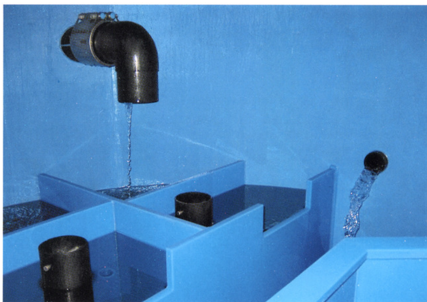
Wassereinlauf in eine Brunnenstube.
