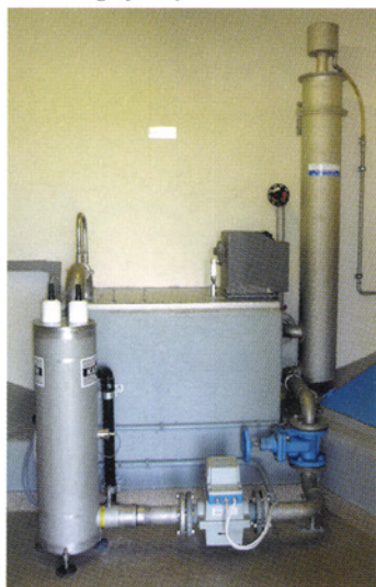
UV-Anlage für Quellen.
