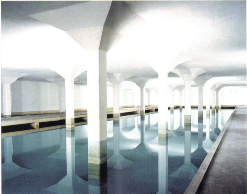
SWW Lengg, einer der 13 Langsamfilter.
