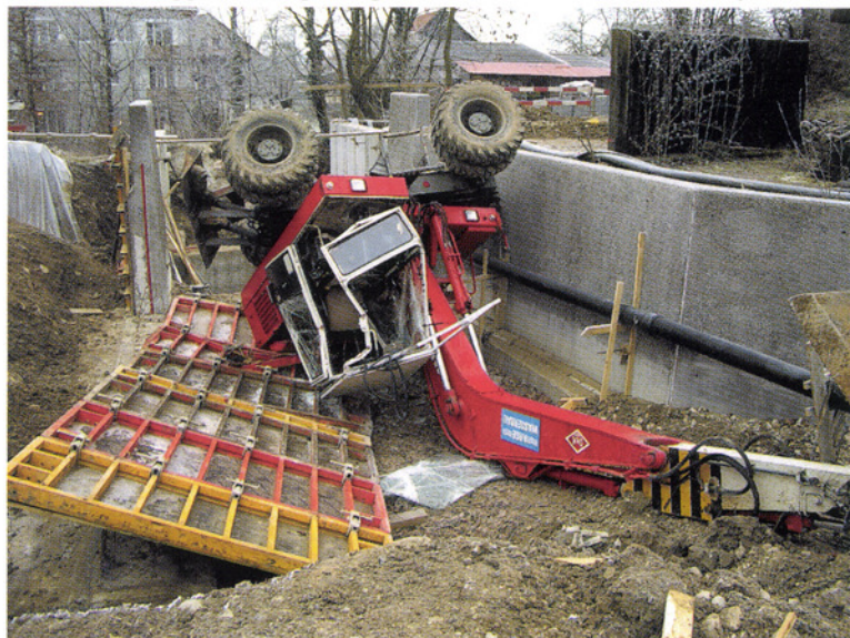
18.01.2005: Bagger in Baugrube gestürzt.
