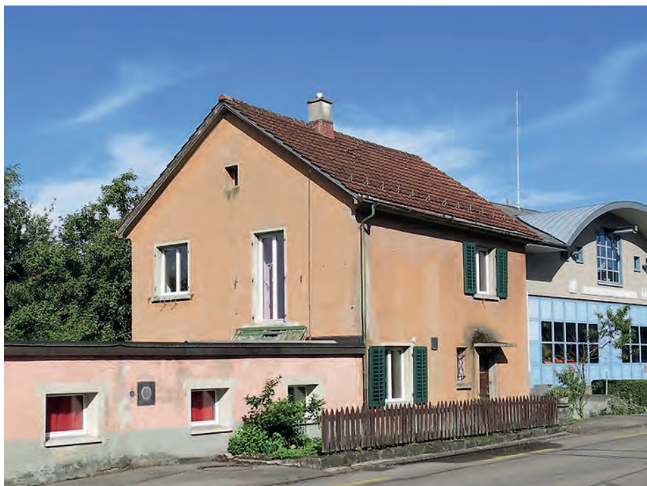
Der Anbau (links) dieser Altliegenschaft der Gemeinde wurde saniert, um darin Asylsuchende unterzubringen.
