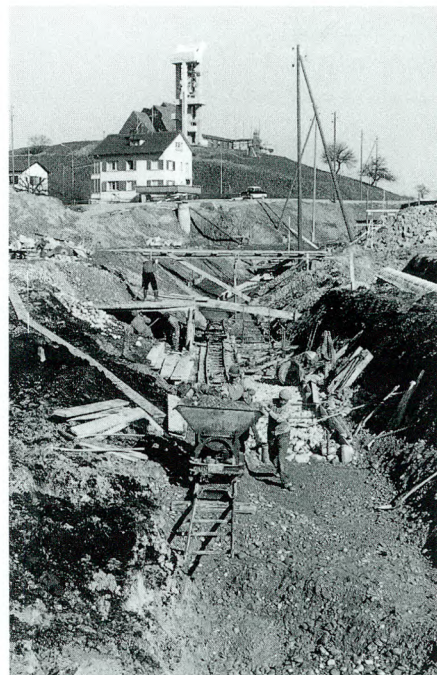
Von Gstarbeitern tiefergelegt: der Grendelbach in Effretikon (1961).
