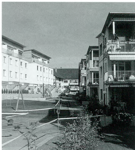
Verdichtete Bauweise: die Überbauung «Illeffi» in Moosburg (Effretikon). (um)
