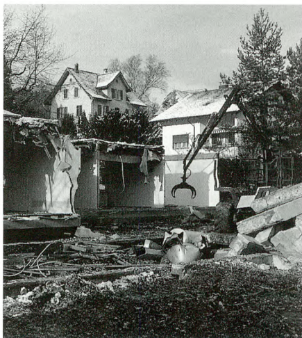
Abbruch des Verwaltungspavillons. (um)
