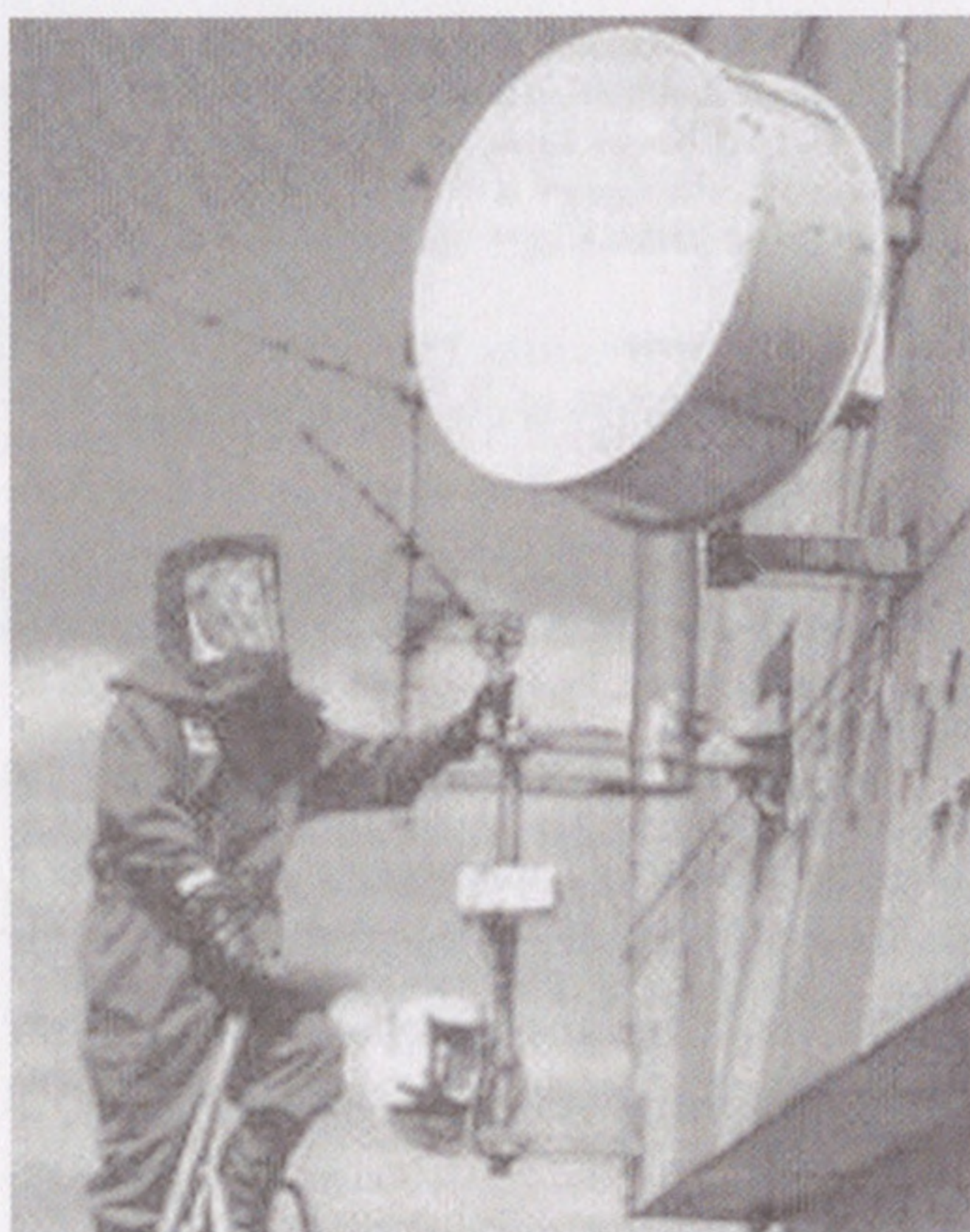
Ein Monteur im Strahlenschutzanzug im Aufstieg zu den Yagi-Antennen eines Privatradiosenders (Richtantenne zum Empfang elektromagnetischer Wellen im Bereich von ca. 10 bis ca. 2000 MHz). Diese Antennen strahlen rund 10-mal schwächer als eine Mobilfunkantenne. Trotzdem trägt der Monteur einen Schutzanzug. (Foto: zvg)
