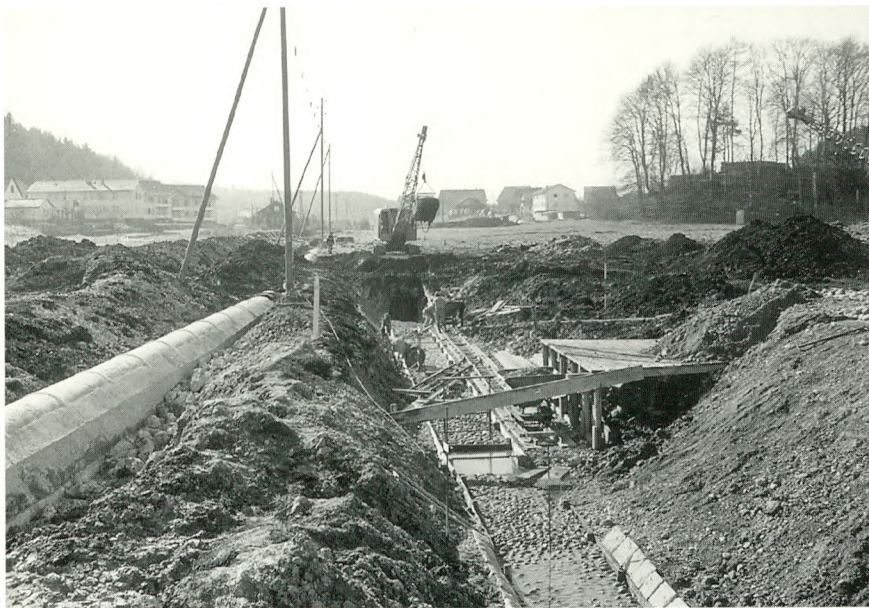
Bauarbeiten am Grendelbach im März 1961. Links ist die freigelegte Bachröhre, in der Bildmitte das neue, tiefere Bachbett zu erkennen.
