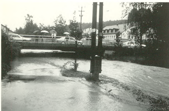
Die Kemptbrücke in Illnau beim Hochwasser 1994
