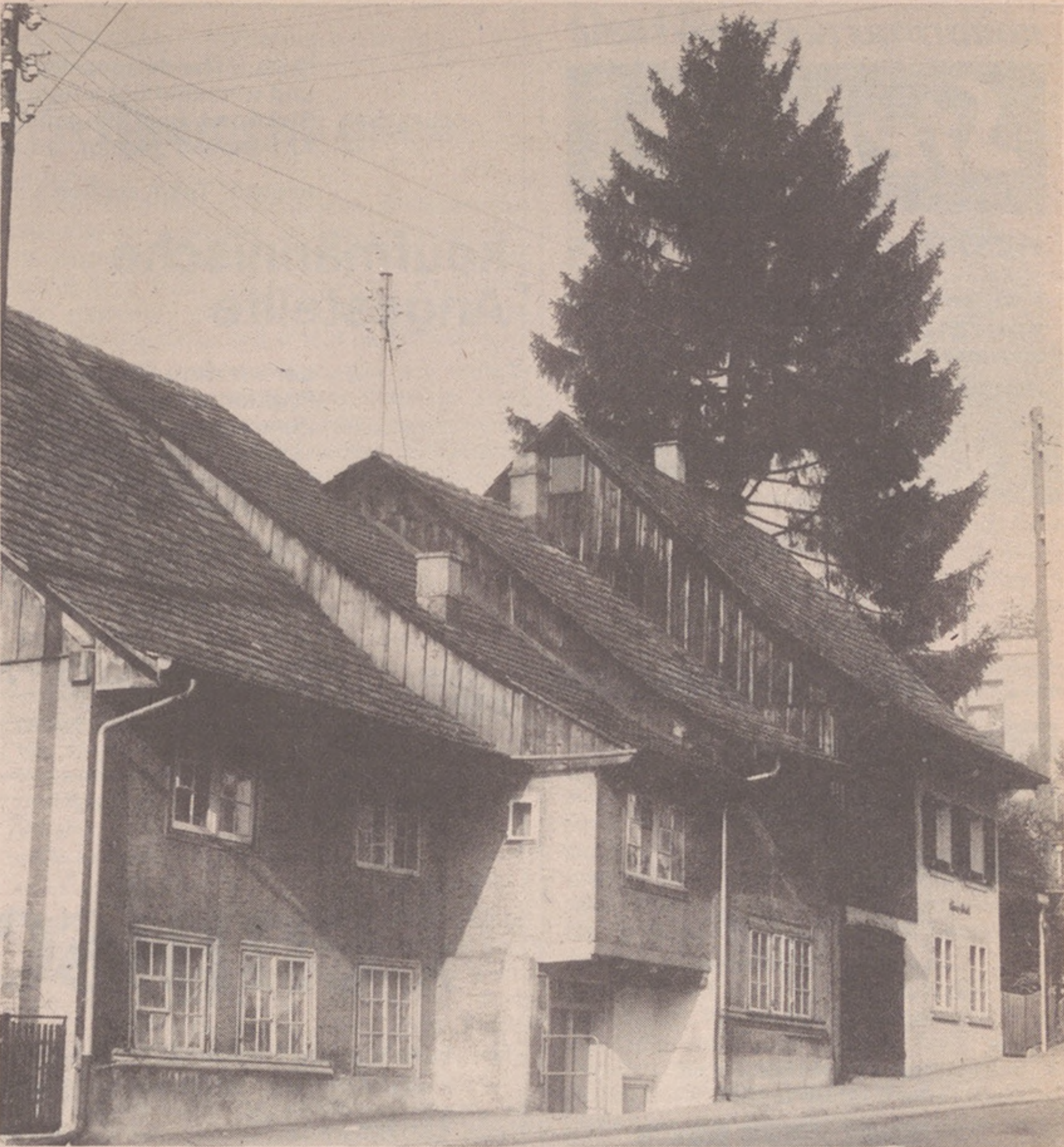
Vom Abbruch bedroht: Häusergruppe an der Gsteigstrasse beim Ortsmuseum Foto: A. Baumann, Höngg, 1978
