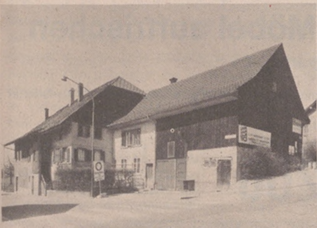
1978 abgebrochen: Teil der Häusergruppe Wieslergasse-Riedhofstrasse. Foto: Baugeschichtliches Archiv der Stadt Zürich, 1971.
