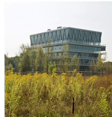
Schulhaus Leutschenbach, erbaut 2008 (Bild: HAL_001928, Juliet Haller)
