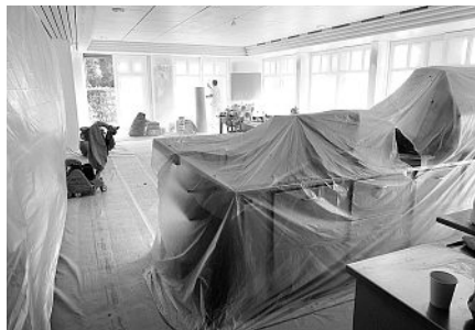
Die Landbeiz im Umbau. Die bestehende Theke ist gegen Staub und Dreck abgedeckt.
