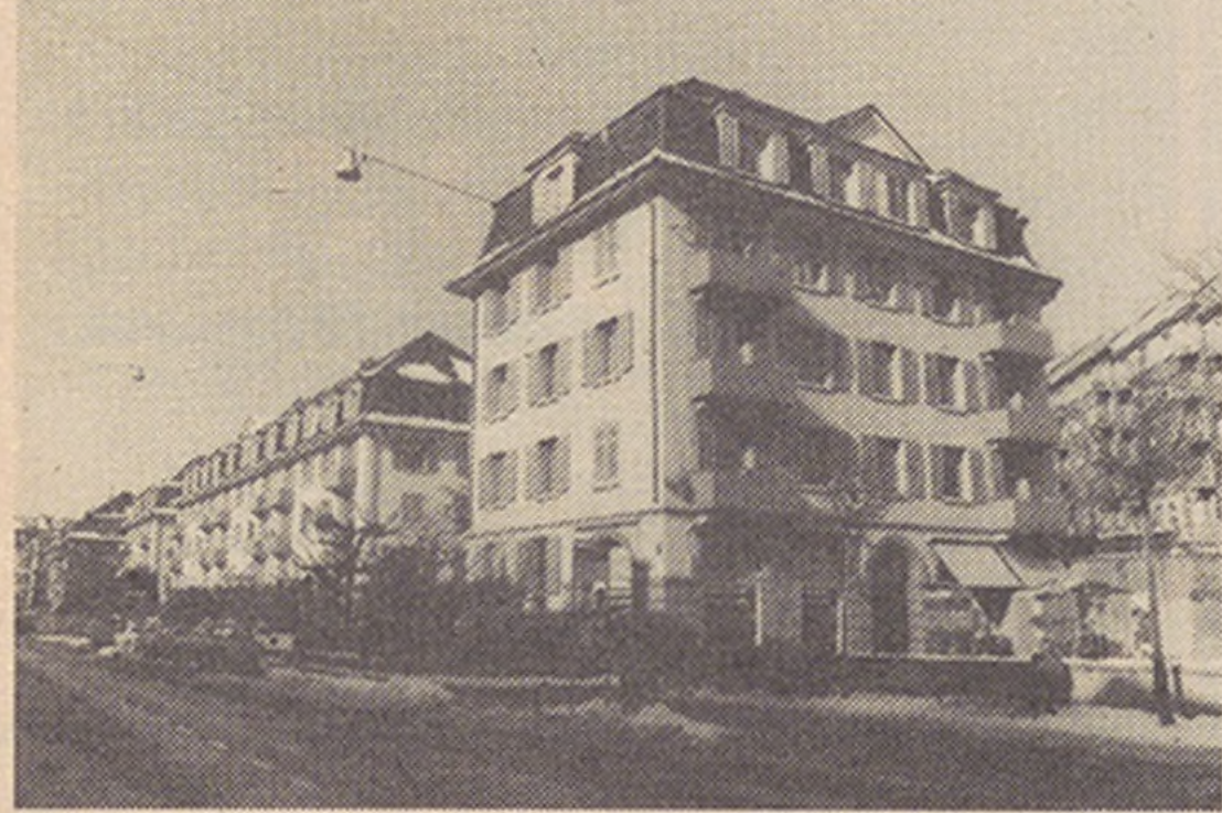
Die betroffenen 106 Wohnungen an der Kornhaus-/Nord-/Weizenstrasse
