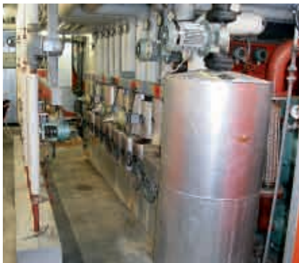
Lüftungszentrale - Enge Platzverhältnisse
