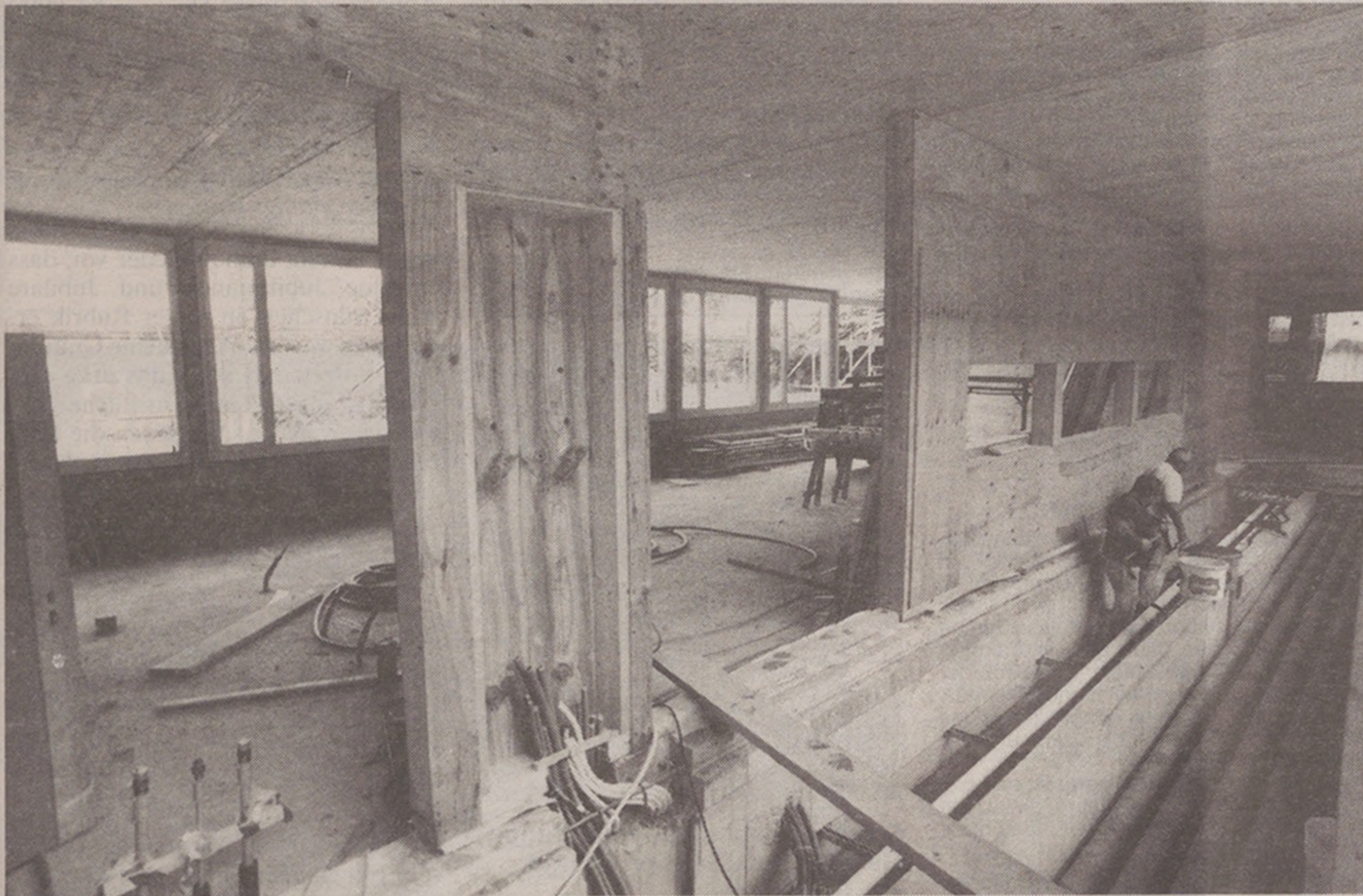
Einblick in den Klassenzimmertrakt – Ausblick gegen die Imbisbühlstrasse
