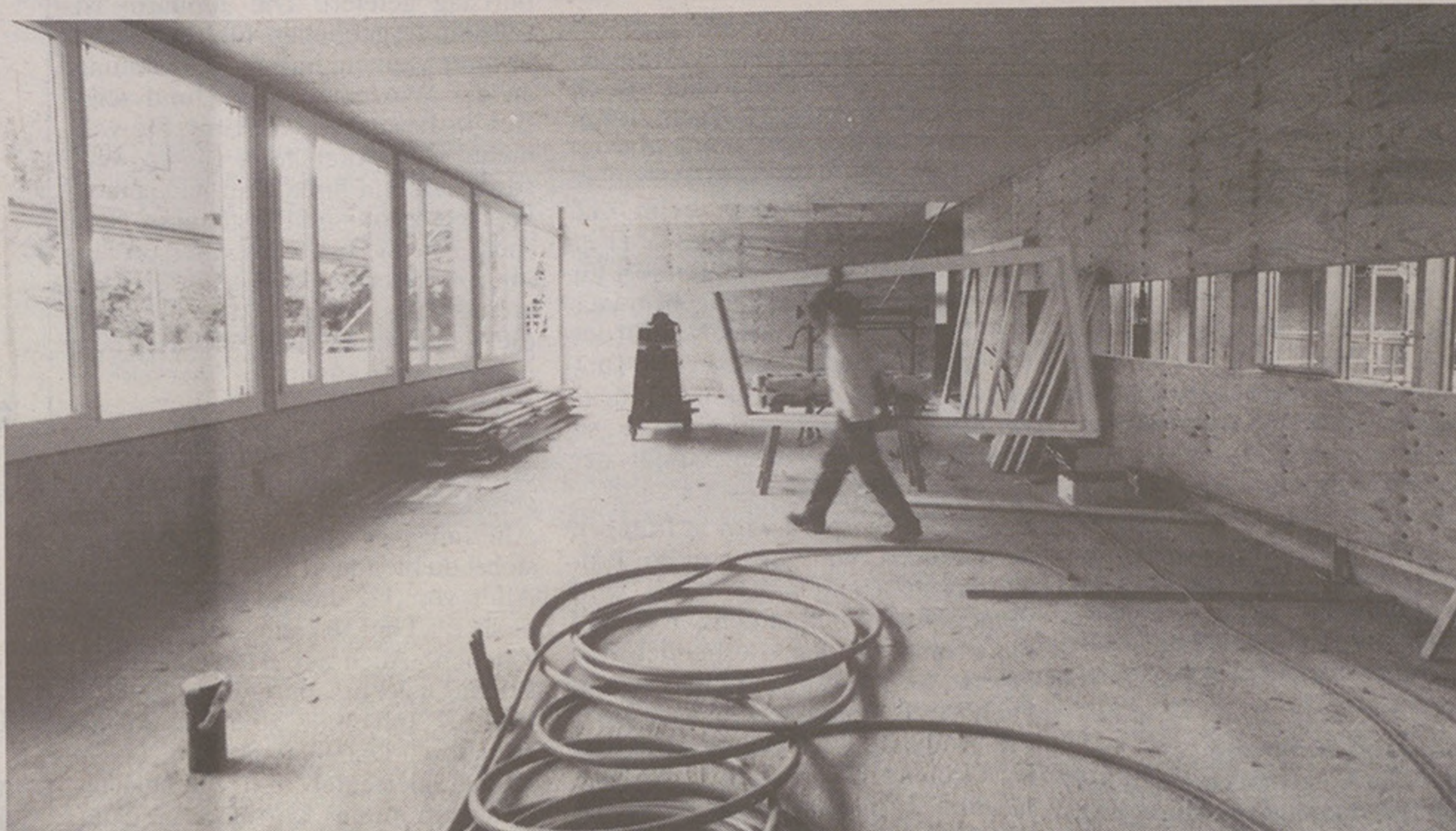
Fenstermontage im neuen Schultrakt
