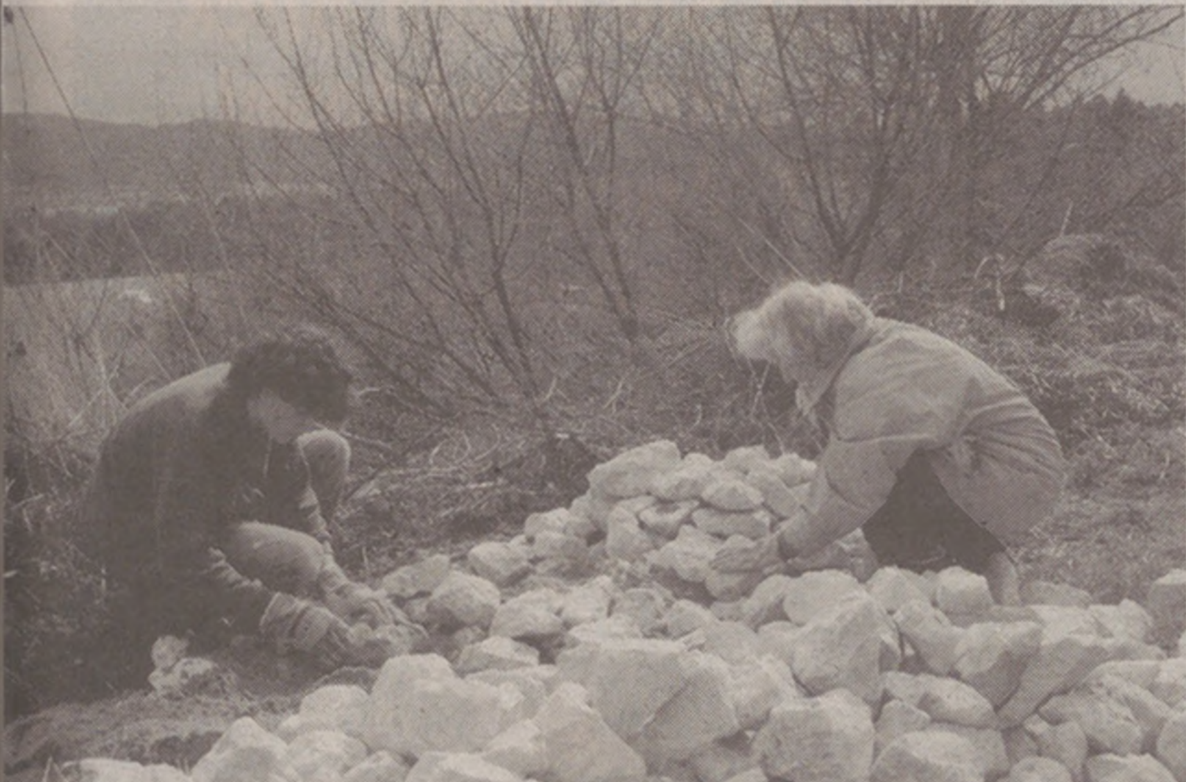
Für den Glögglifrosch erstellte der NVV Hönegg zahlreiche Unterschlüpfe und als Hauptwerk eine acht Meter lange Trockenmauer.
