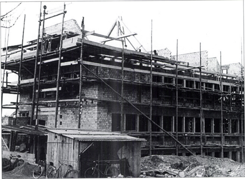
Schulhaus Pünt 1941, Gerüst mit Bauaufzug links.
