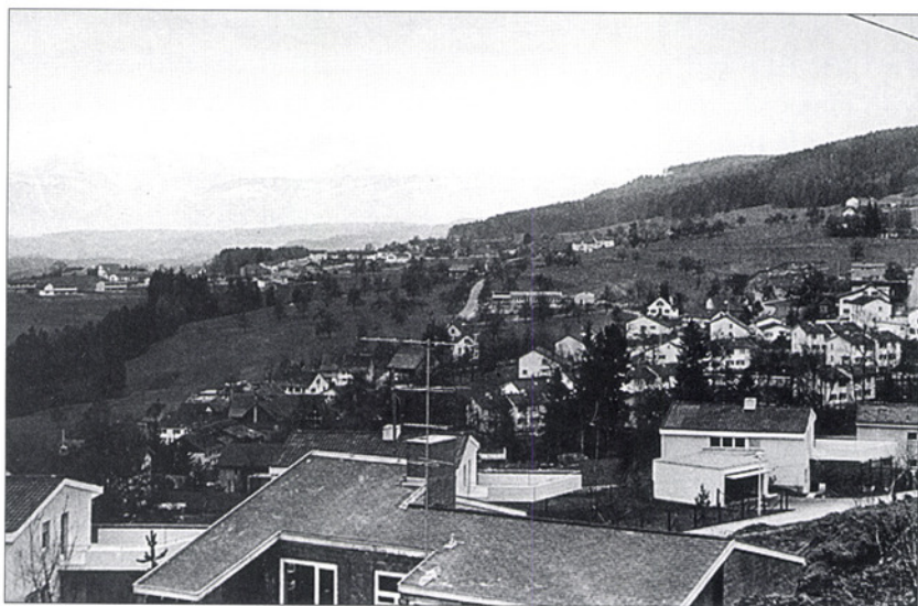
Schulhaus Aesch im Bau mit Blick vom Wassberg auf das Baugelände.
