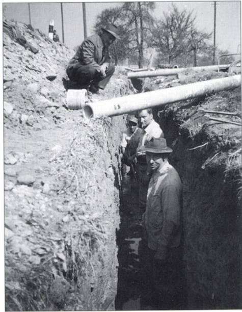
Wasserleitungsbau von Maur nach Aschbach 1956.
