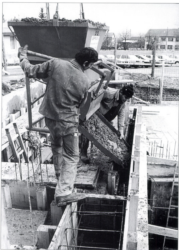
Erweiterung Gemeindehaus 1981, die Wand zum Polizeiposten wird betoniert.
