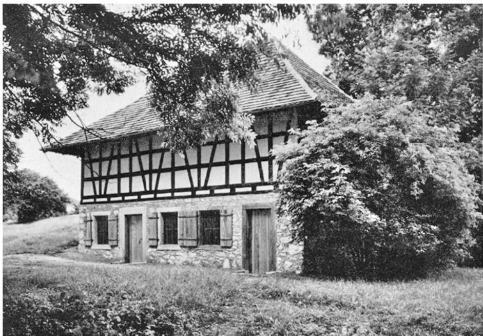
Hettlingen – Alte Hanfreibe («Hauf- rybi»), nach der Renovation von 1960.
