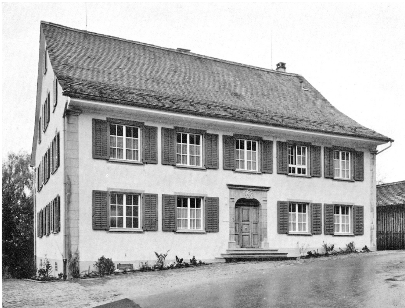
Lindau – Pfarrhaus, nach der Gesamtrenovation von 1960/61. Strassenfassade.
