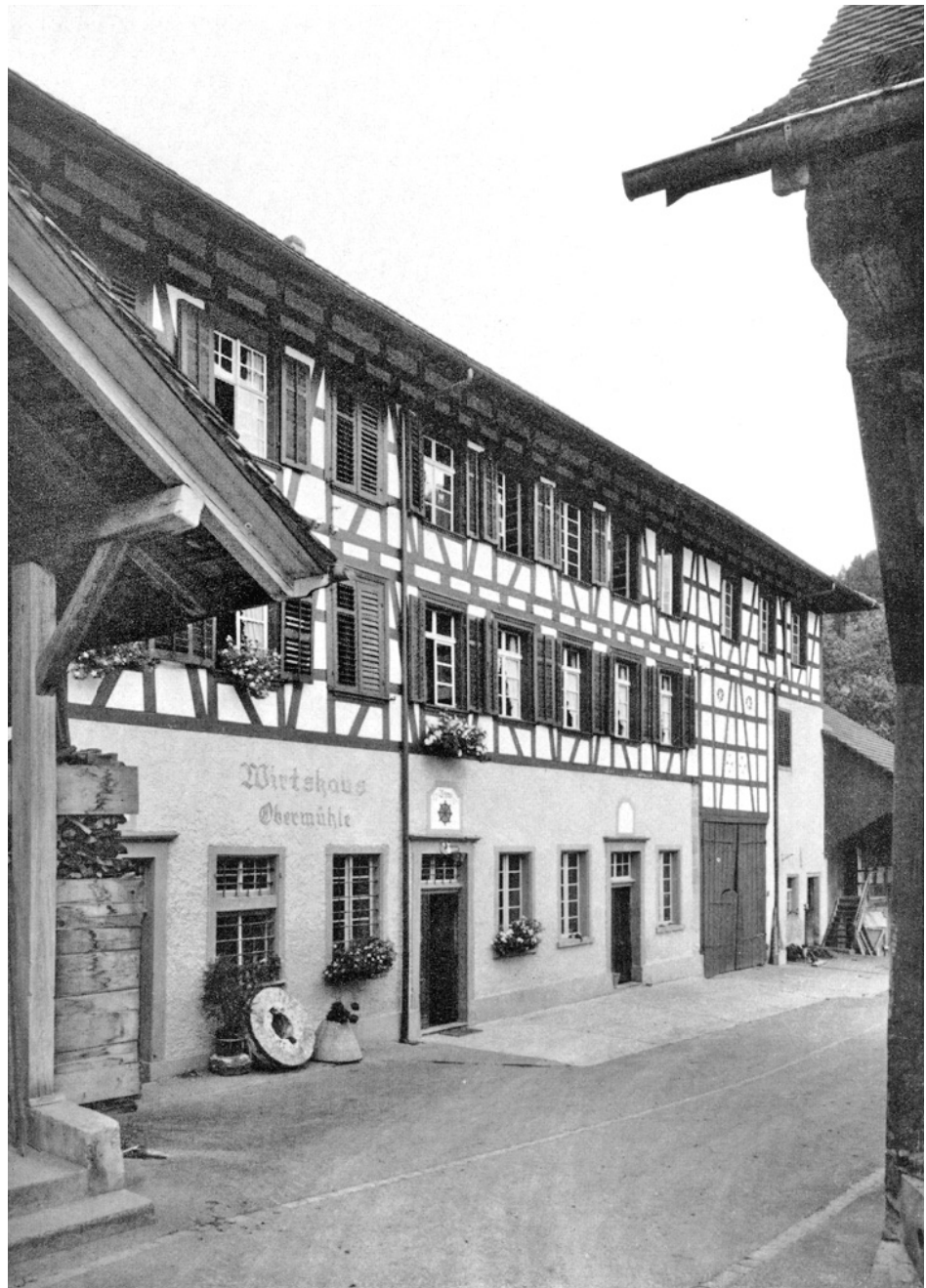
Flaach – Wirtschaft zur «Obermühle». Hauptfassade nach der Renovation von 1961.
