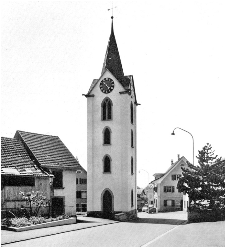
Wallisellen – Rieden. Riedenerstrasse: Turm von 1866, aus Norden.
