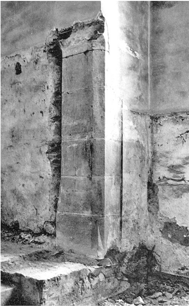
Knonau – Reformierte Kirche. Südlicher Pilaster (Sandstein) des ehemaligen gotischen Chorbogens, freigelegt während der Restaurierung 1960.
