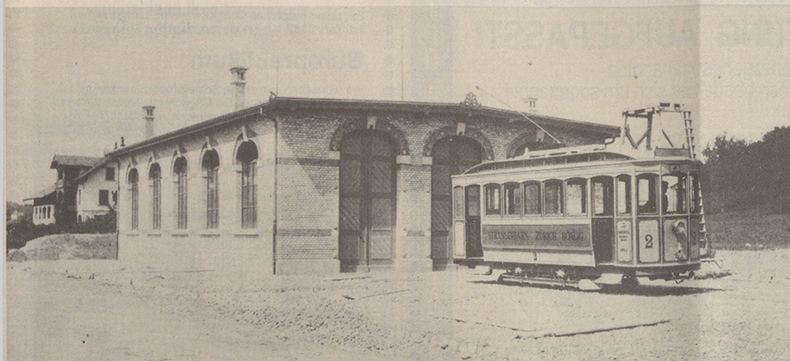
Das Depot bei der «Wartau» der ehemaligen Strassenbahn Zürich-Höngg (Z-H) mit Motorwagen Ce 22 2 im Eröffnungsjahr 1898. Foto: MFO, Archiv TMZ
