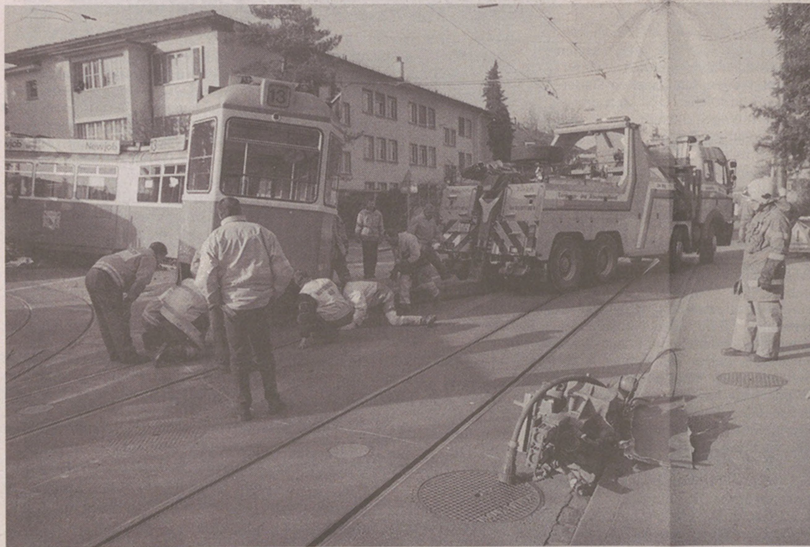
Die Bergung des Tramzuges erwies sich als schwierig und zeitraubend. Während rund sechs Stunden war die Limmattalstrasse zwischen Restaurant Limmattberg und Haltestelle Winzerstrasse gesperrt.
