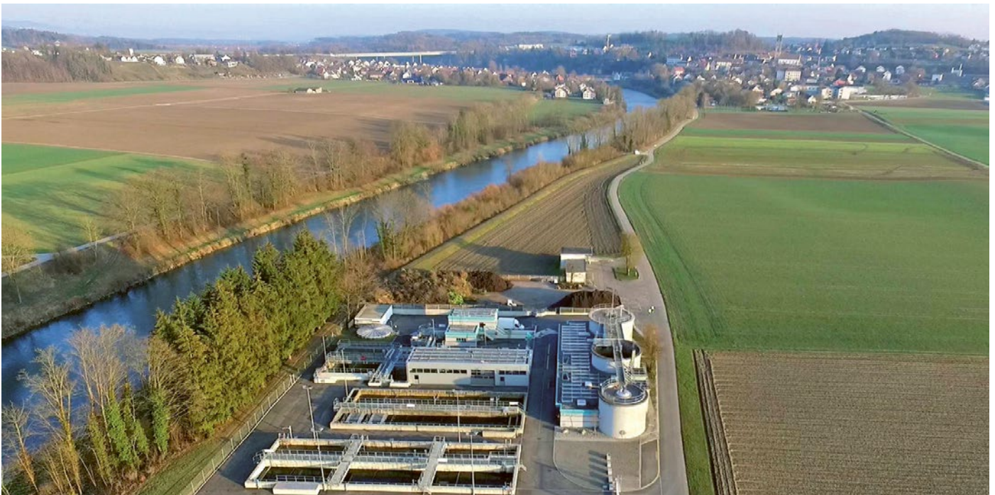
Vogelschau auf die Kläranlage
