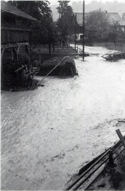
Abb. 7: Überschwemmung des Dorfbachs im Unterdorf 1953.
