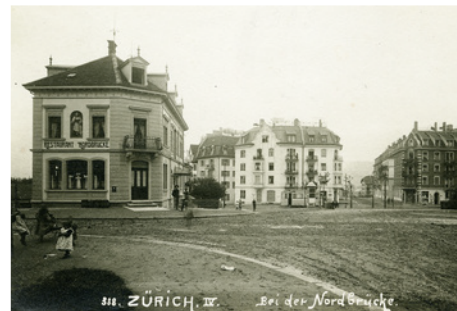
Ab 1908 zwischenzeitlich mit Tram-Endstation: Der Röschi-Strassenplatz (Bild: BAZ_097007, Friedrich Ruef-Hirt)
