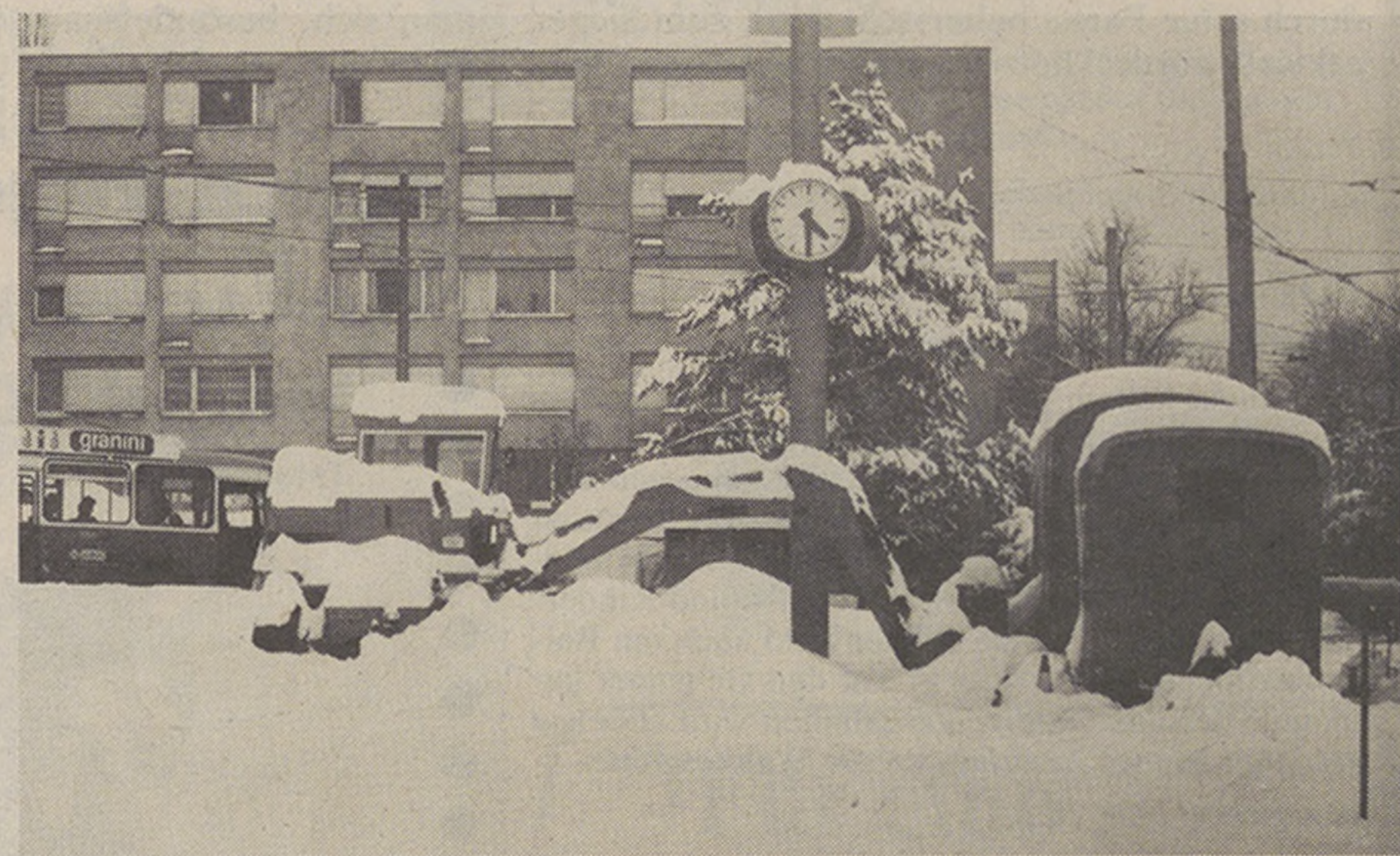
Eingeschneite Baumaschine an der Endstation Frankental.
