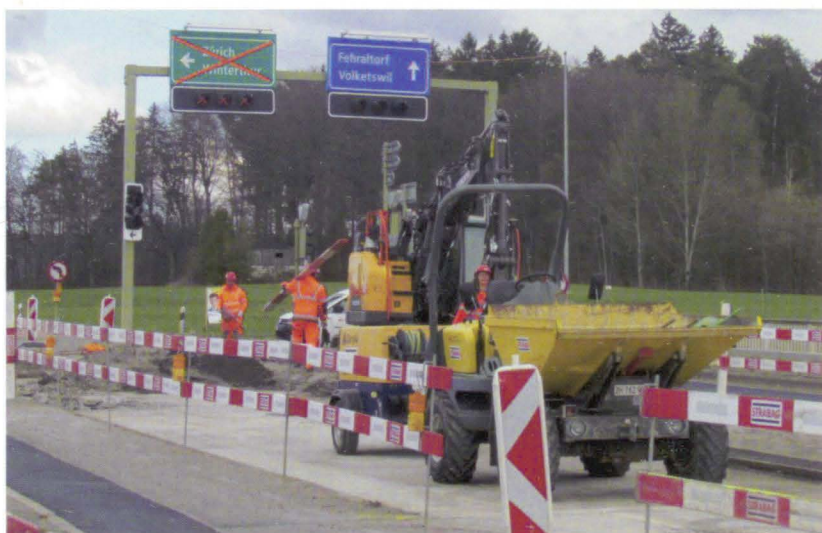
«Waro»-Kreuzung wird saniert und bleibt bis Ende Oktober nur beschränkt befahrbar.
