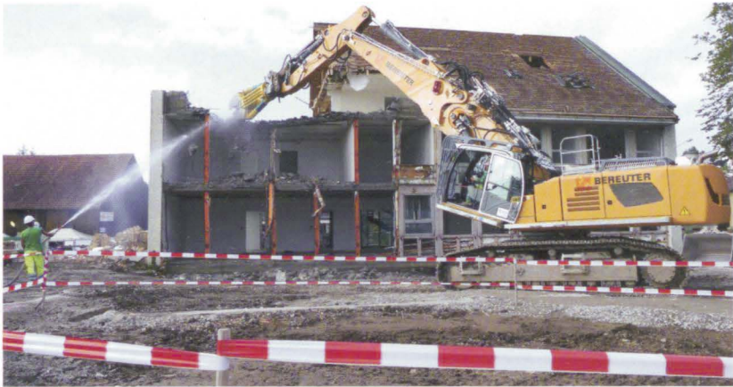
Jetzt geht es dem alten Gemeindehaus an den Kragen: Ein Bagger des einheimischen Bauunternehmens reißt das 60-jährige Gebäude ab. Bild: zvg.
