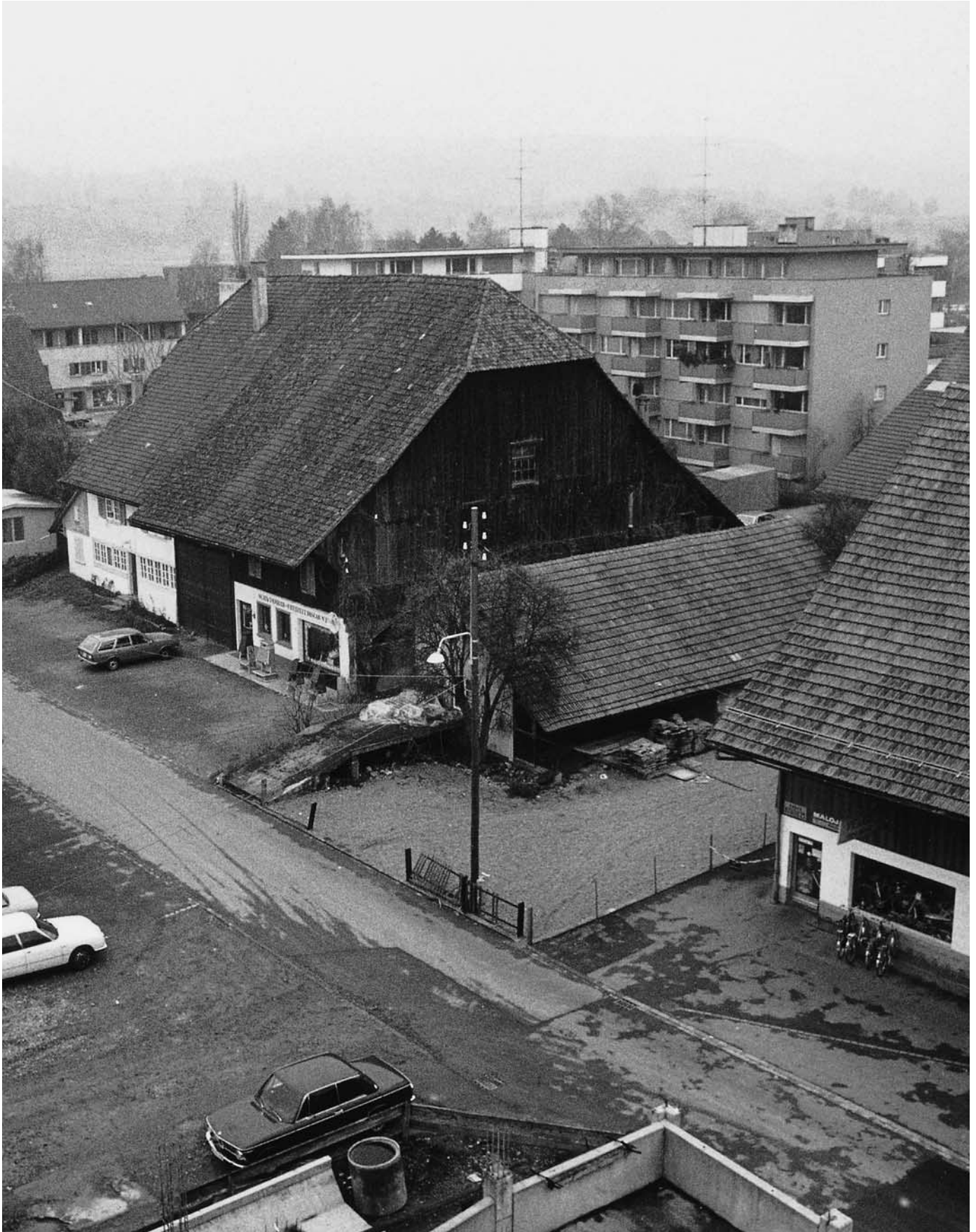
Kloten, ehem. Bauernhaus, sog. Höchhus
