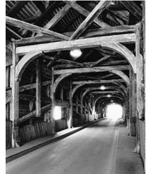
Innenansicht der instandgestellten Brücke Richtung Norden. Zustand 1999.
