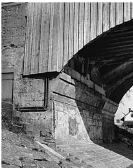
Das nordöstliche Widerlager der instandgestellten Brücke. Zustand 1999.
