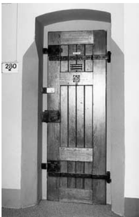
Zellentüre, Zustand vor dem Abbruch 1995.
