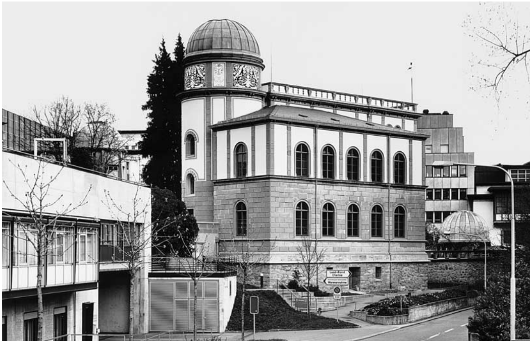
Nord- und Westfassade der Sternwarte nach der Restaurierung, Zustand 1997. Im Vordergrund die Spöndlistrasse, rechts im Hintergrund das kleine Observatorium von 1911.
