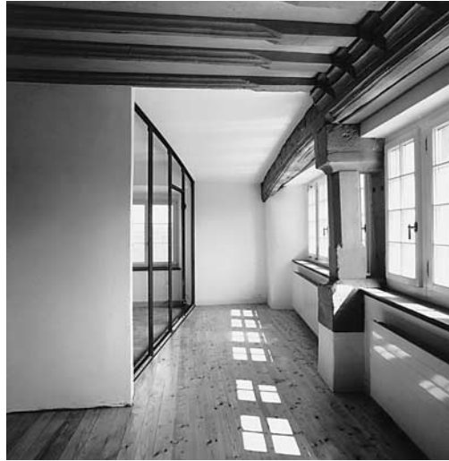
Links: Die Nordoststube mit der Zwischenwand während der Renovation. Zustand 1993.
