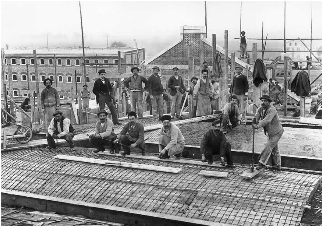
Die Strafanstalt im Bau, Zustand am 1. Dezember 1899. Arbeiten an der Hourdisdecke des Zentralbaus. Im Hintergrund links das Frauengefängnis. Aufnahme von Kantonsphotograph Emil Gujer (1872–1946).
