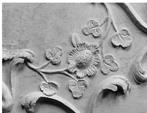
Links: Detail der Stuckdecke von 1758 im Chor. Zustand 1996.
