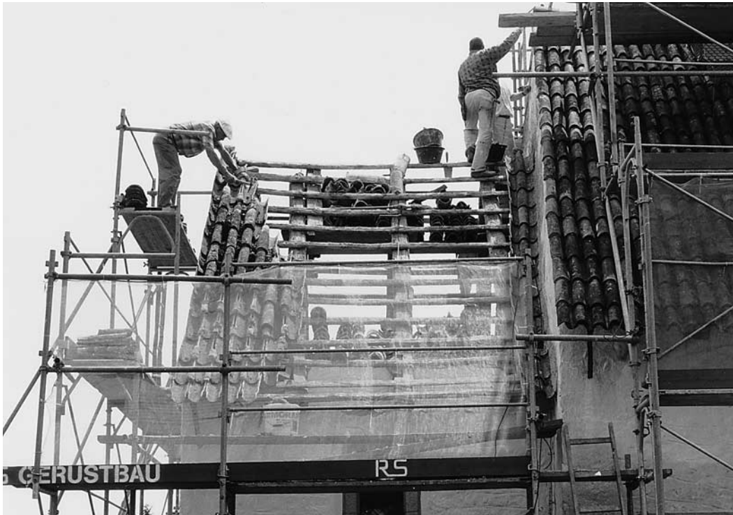
Neueindeckung der Dächer im Sommer 1996.
