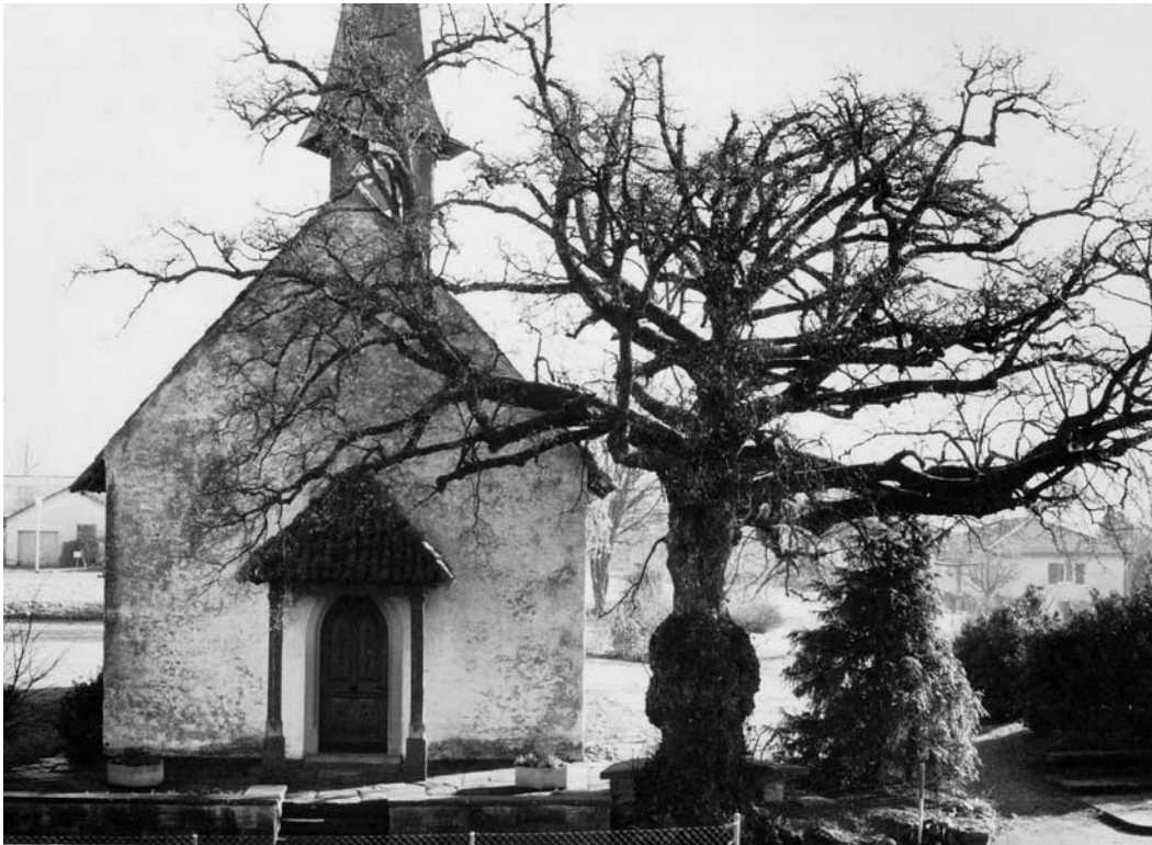
Ansicht der Kapelle von Westen mit der charakteristischen Linde, vor der Restaurierung, Zustand 1995.
