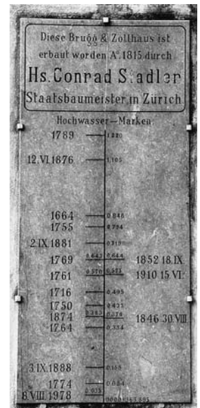
Inscripttafel am nordöstlichen Widerlager der 1814–1815 neu errichteten Brücke. Zustand 1999.
