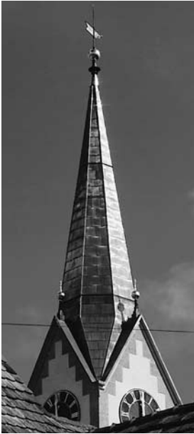
Der Turmhelm mit der neuen, glänzenden Kupferblechabdeckung, Zustand 1995.
