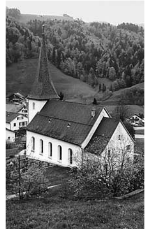
Ansicht von Westen, mit dem 1994 abgebrochenen Westanbau von 1936. Zustand 1983.
