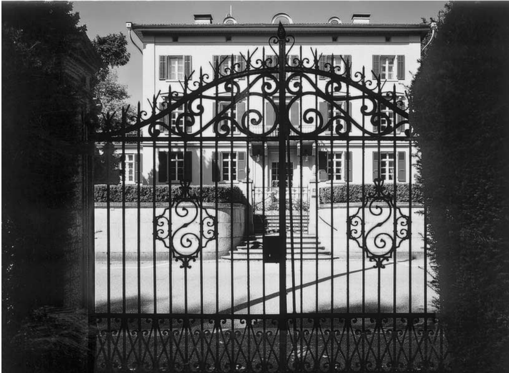
Hauptfassade der Villa nach der Renovation, Zustand 2000. Neuverputzt mit ursprünglichem, 1927 beibehaltenem ockergelbem Anstrich. Beim Umbau 1926–1927 wurde die Fassade teilweise purifiziert, vgl. Abbildung Seite links. Im Vordergrund Gartenportal, erstellt 1911 vom Baugeschäft Knell & Leemann, Horgen, mit dem Zierbuchstaben S (=Streuli) in Medaillons.
