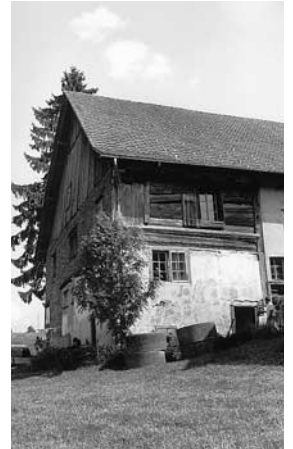
Nordwestfassade mit Bohlenständerwand im Obergeschoss. Zustand 1992.
