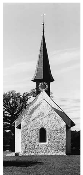
Ansicht der Kapelle von Osten, Zustand 1996.
