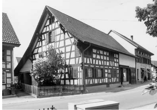
Links: Horgen, Doppelwohnhaus Klausenegg Vers. Nrn. 1480/1491, Vorder Klausen, Bergstrasse, nach Dach- und Fassadenrenovierung 1995–1996.
