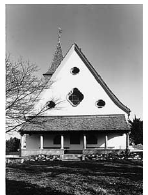
Westfassade nach der Restaurierung, Zustand 1997.
