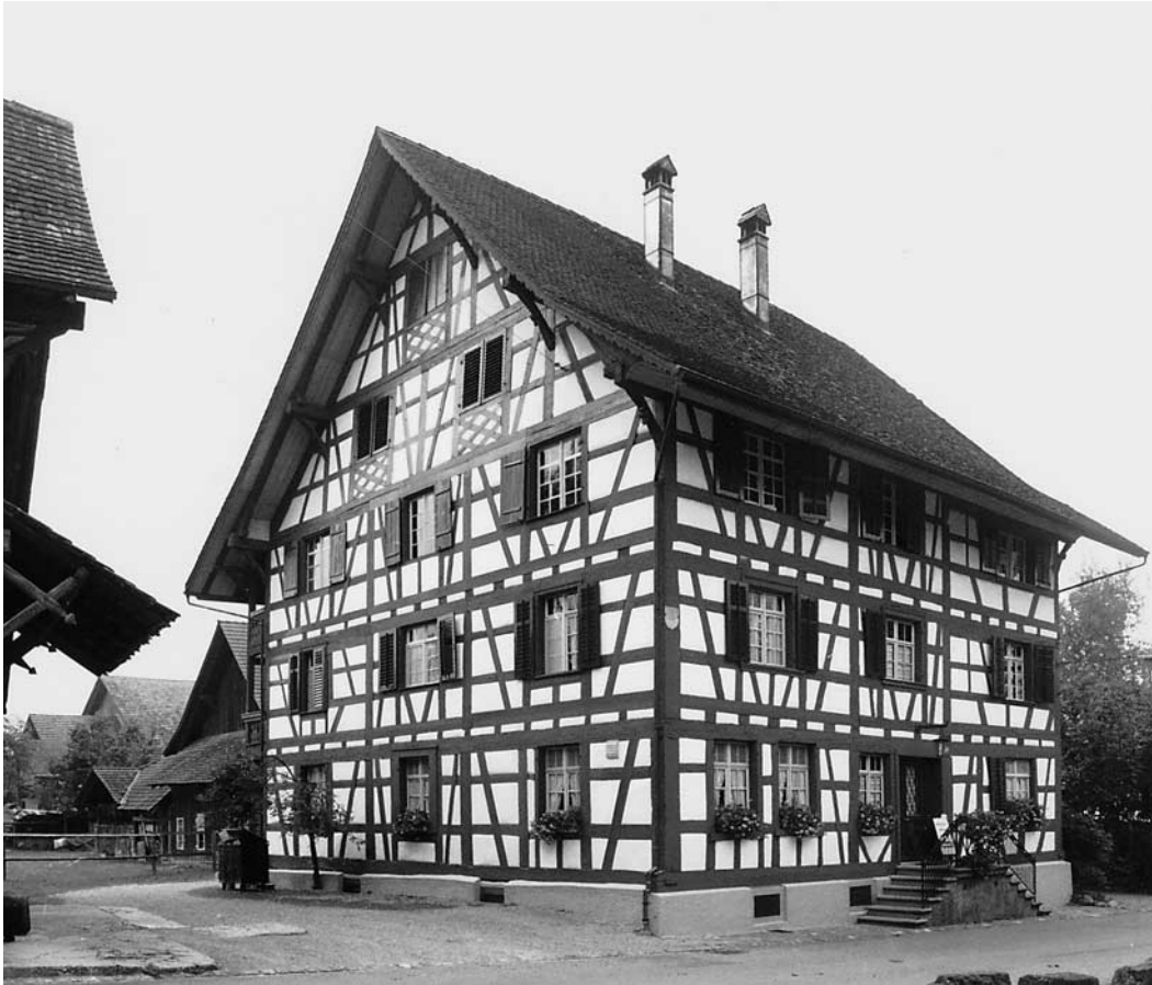
Nordwest- und Nordostfassade nach der Aussenrenovation, Zustand 1994.
