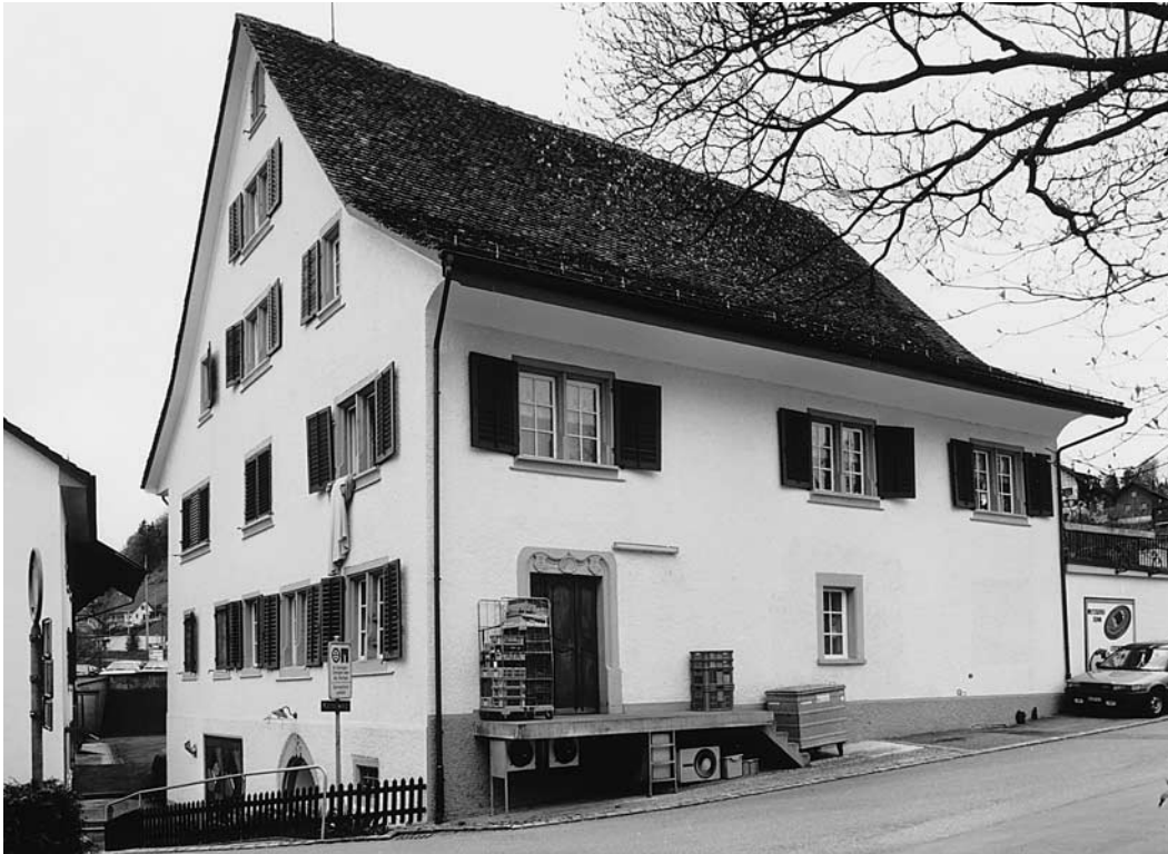
Die ehemalige Mühle nach der Renovation 1995–1996. Zustand 2000. Vgl. Abb. Seite links.
