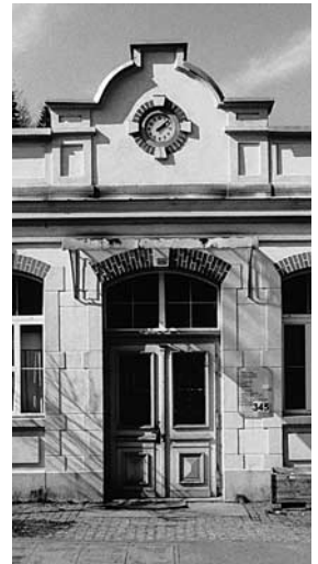
Eingangspartie der 1906 erbauten Weberei, Zustand 2000.
