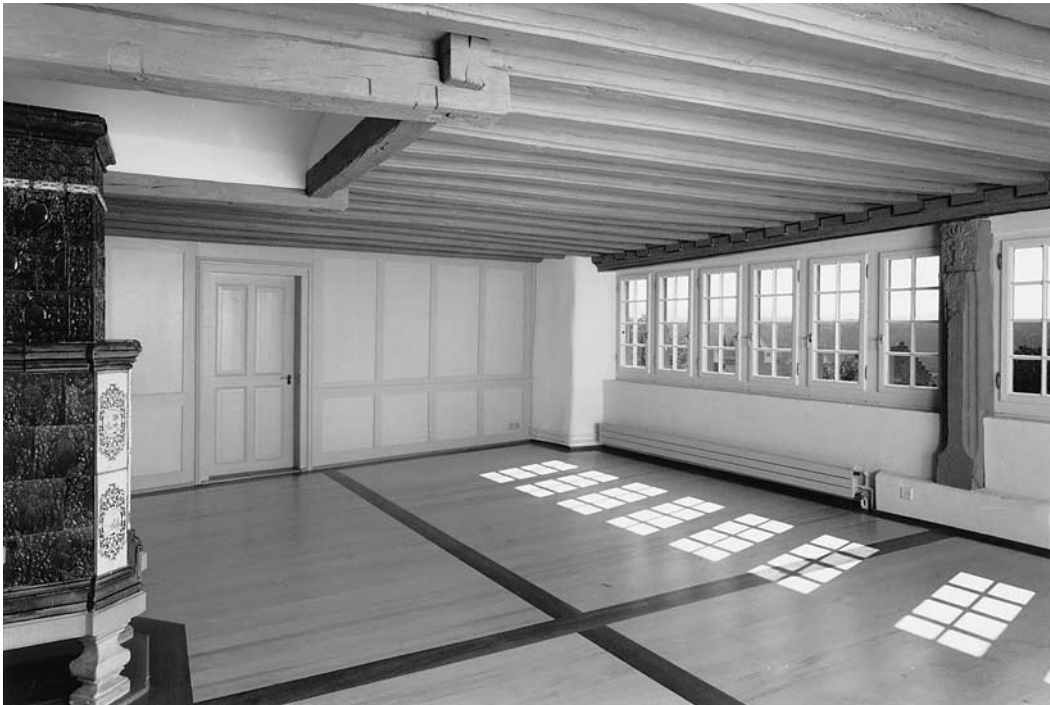
Die Südoststube mit der spätgotischen Bohlenbalkendecke ist in den alten Ausmassen wiederhergestellt, die durchgehende Fensterreihe (Fensterwagen) rekonstruiert worden. Zustand 1994. Vgl. Bild gegenüberliegende Seite.
