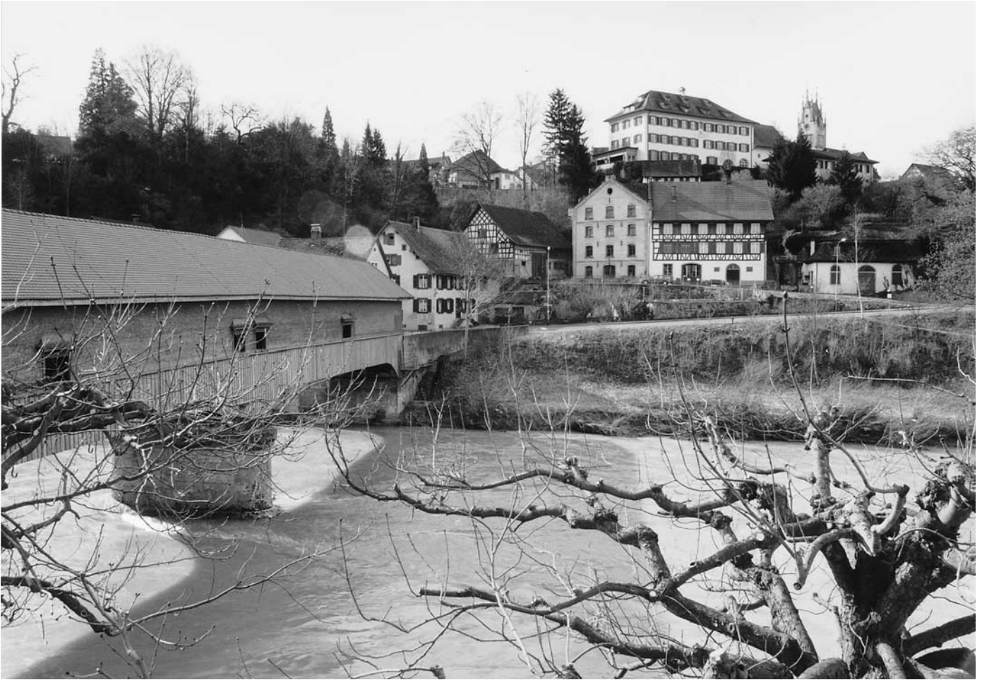
Oben: Ansicht der Thurbrücke flussaufwärts, nach der Instandstellung, Zustand 1999. Rechts oben das Schloss, darunter die Haldenmühle.
