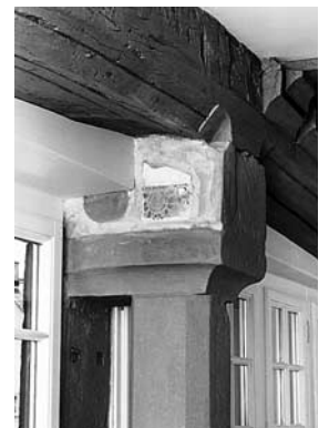
Teilansicht der Fenstersäule und der Deckenkonstruktion in der Nordoststube. Zustand 1994.
