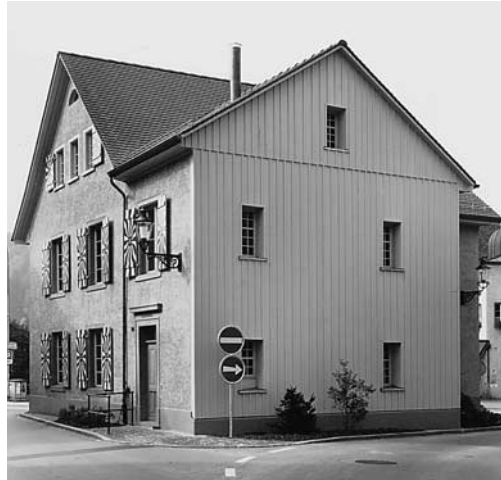
Links: Nordfassade vor der Renovation, Zustand 1987. Rechts: Ost- und Südfassade nach der Renovation, Zustand 1994. Der 1818/1819 in Fachwerk erstellte Anbau wurde mit Brettern verkleidet.
