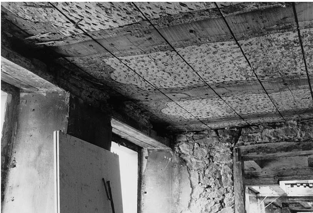
Bemalte Decke im 1. Obergeschoss des südöstlichen Hausteils (Seestrasse 149). Zustand während der Bauarbeiten 1996. Grauer Grund, weisse Spiegel, die an den Schmalseiten mit Einzug halbrund schliessen. Wohl zweite Hälfte des 17. Jahrhunderts.
