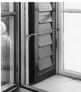
Innenladen in der Fensterläubung im Raum 2.8, 2. Obergeschoss. Nach der Restaurierung, Zustand 1999.
