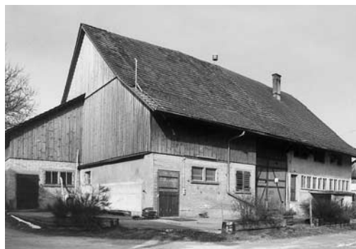
Links: Kleinandelfingen, ehem. Waschhaus Vers. Nr. 416, bei Hinterhofstrasse 12, nach Renovation 1995.
