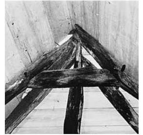
Detail der Dachkonstruktion, sog. Walm-Anfallspunkt. Zustand 1998.
