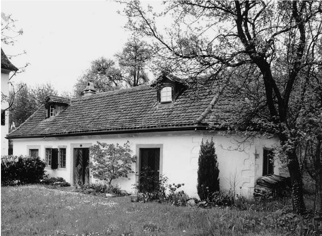
Das um 1762 erbaute Waschhaus nach der Renovation, Zustand 2001.
