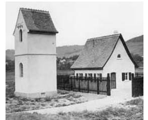
Die Trafostation von 1922 (links) und die Pumpenstation von 1924 (rechts) bildeten eine «malerische» Baugruppe im Sinne des Heimatschutzes. Zustand 1925, Photo aus Dok. 4.
