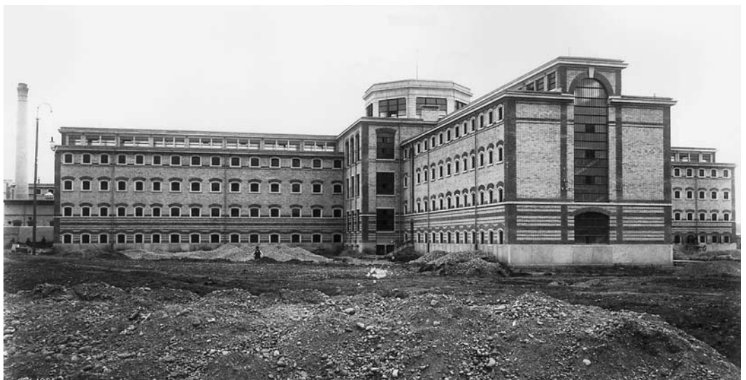
Südwestansicht des Hauptgebäudes am 7. Oktober 1901, unmittelbar vor dem Bezug durch 213 Sträflinge in der Nacht vom 8. auf den 9. Oktober 1901. Im Hintergrund der Kamin des Wirtschaftsgebäudes. Photo von Kantonsphotograph Emil Gujer (1872–1946).
