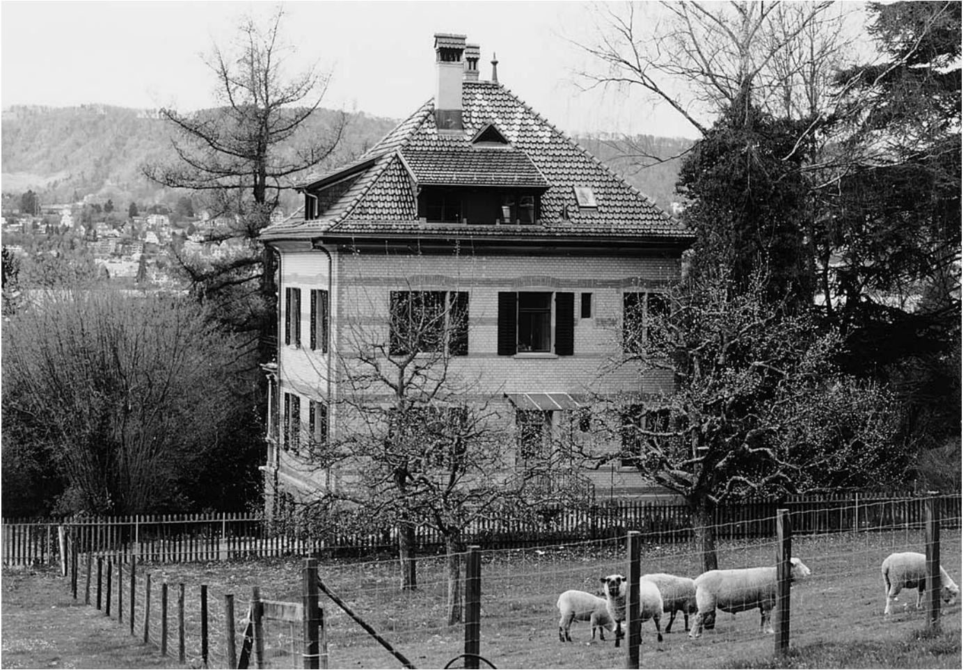
Oben: Ansicht des 1903 errichteten Hauses von Osten. Zustand 1997, nach der Renovation.
