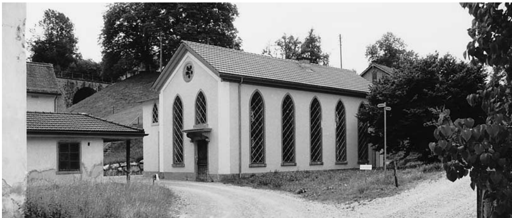
Das 1872 in neugotischen Formen erstellte Werkstattgebäude Vers. Nr. 512 nach der Aussenrestaurierung. Zustand 1999.
