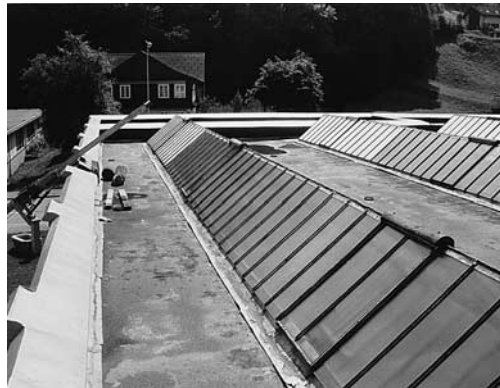
Links: Das 1906 erbaute, sogenannte Meisterhaus während Umbau und Renovation, Zustand 1994.
