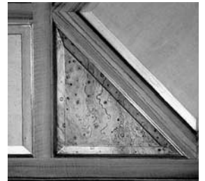
Wurzelholzmaserierung auf Gips an einer Decke im Erdgeschoss, nach der Renovation, Zustand 1995.
