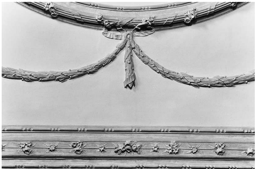
Rechts: Detail der 1816 geschaffenen Deckenstuckatur, nach der Restaurierung, bei der die ursprüngliche Farbigkeit wiederhergestellt wurde: graue Dekorationsformen auf gebrochen weissem Grund, pflanzliche Elemente gelb. Zustand 1996.
