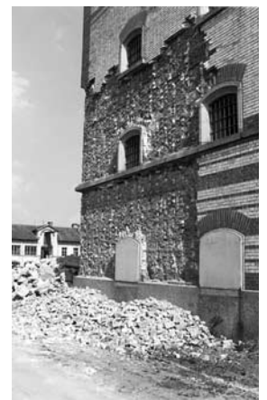
Abbrucharbeiten am Frauenzellenbau am 4. März 1995: Entfernung der 12 cm starken Backsteinverblendung an der Betonaussenmauer.
