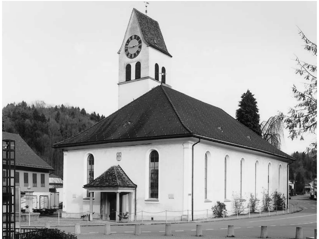
Aussenansicht der Kirche. Turm 1651–1652, Schiff 1769–1770. Zustand 1996.
