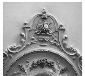
Detail des farbig gefassten Mittelmedaillons der Stuckdecke im 1. Obergeschoss nach der Renovation, Zustand 1995, vgl. Abb. links.
