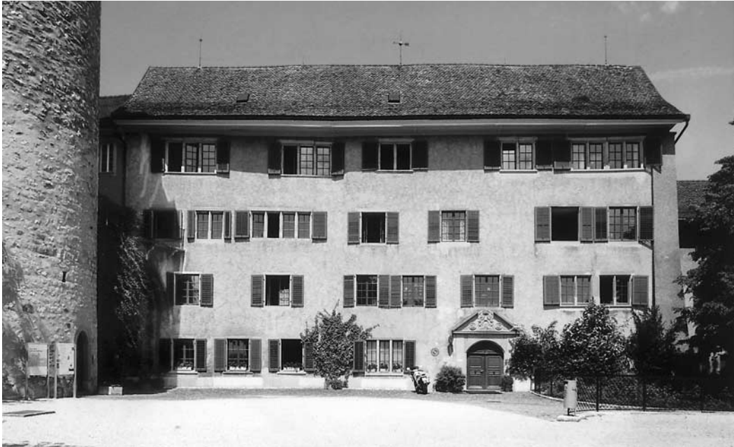
Hofansicht des 1583–1585 umgestalteten und 1994–1996 letztmals renovierten Schlosses, Zustand 2000. Das Hauptportal stammt von der Renovation 1685. Im 2. Obergeschoss links die vierteilige Fenstergruppe der ehemaligen Gerichtsstube. Links der Rundturm.
