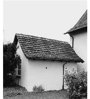
Der 1940 erstellte, als kirchlicher Annexbau getarnte Bunker wurde 1996 unter Schutz gestellt. Zustand 2001. Vgl. Abbildung unten.
