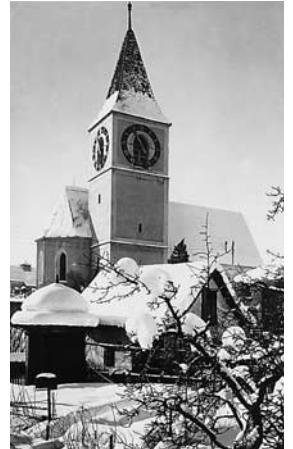
Die Kirche von Norden. Zustand vor der Entfernung des Verputzes am Turm 1921–1922. ZBZ, graph. Slg.
