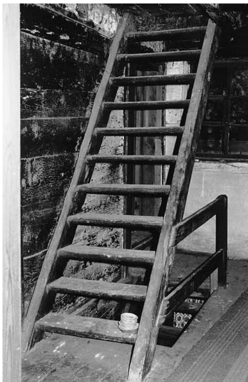
Links: Bohlenwand und Treppe im 1. Obergeschoss. Zustand 1994. Rechts: Einbauschränk in der Stube im Erdgeschoss. Zustand 1994.
