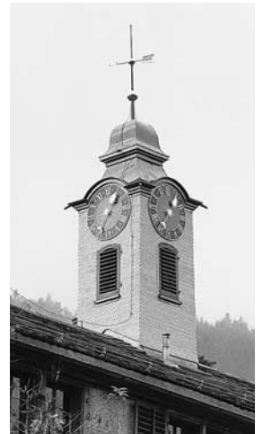
Der Dachreiter von 1841 auf dem Wohnhaus von 1834. Zustand 1977.
