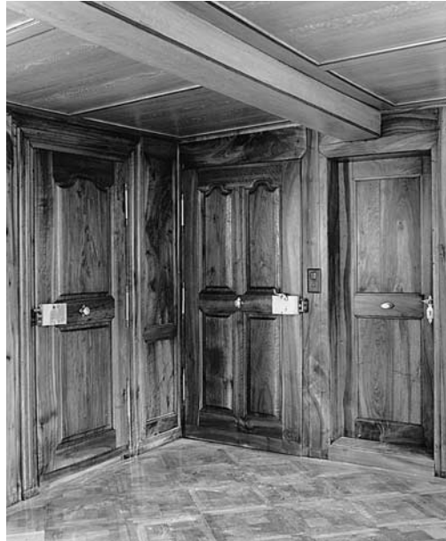
Links: Korridor im 1. Obergeschoss nach der Restaurierung. Zustand 1994.
