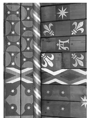
Detail der Dekorationsmalerei von 1921/1934 an der abgestuften Altarüberdachung. Zustand 1992.
