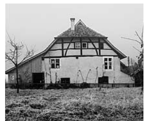
Ansicht von Osten. Zustand 1998. Der Anbau links erfolgte 1861.
