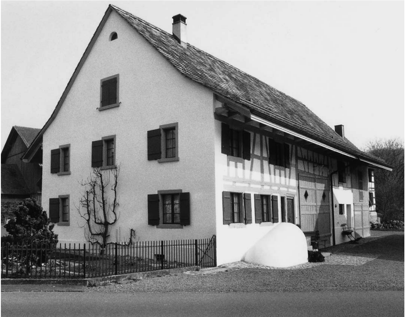
Oben: Aussenansicht des 1995–1996 renovierten Bauernhauses mit dem markanten Kellerhals. Zustand 1997.
