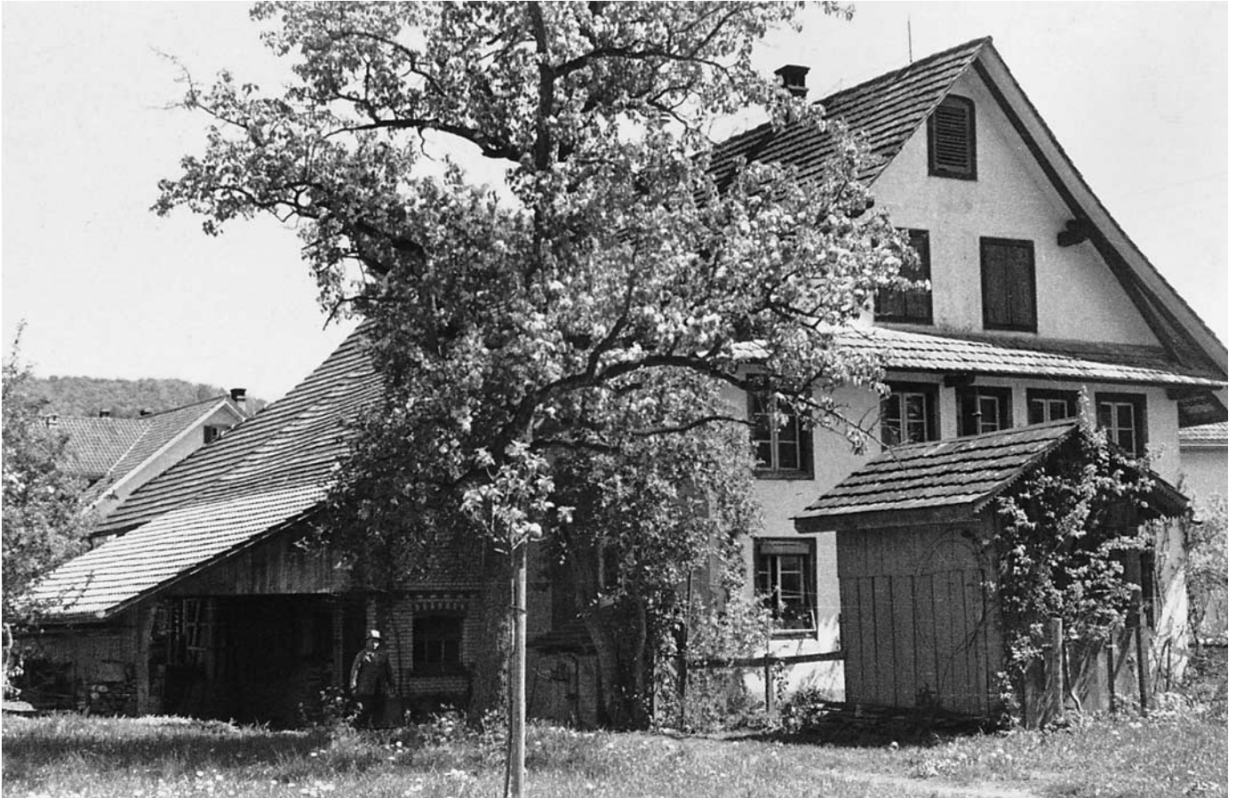
Oben: Bonstetten, Das Bauernhaus Vers. Nr. 192 mit dem noch nicht restaurierten Bienenhaus Vers. Nr. 193 (rechts).
