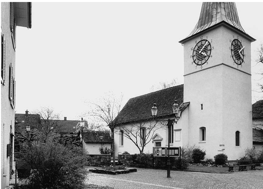
Teilansicht der kirchlichen Baugruppe mit dem 1940 erstellten Bunker. Zustand 2001. Vgl. Abbildung oben.
