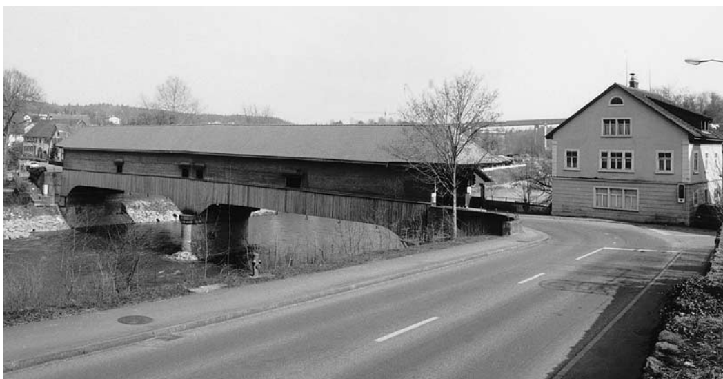
Ansicht der instandgestellten Brücke von Südwesten. Rechts das 1817 durch Staatsbauinspektor Hans Conrad Stadler (1752–1819) erbaute, bis 1839 im Betrieb stehende und um 1870 umgebaute Zollhaus. Zustand 1999.
