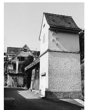
Die 1916 nach dem Typenplan D 270 erstellte Trafostation blieb als Bestandteil des Industrieensembles erhalten. Zustand 1994. Im Hintergrund das Meisterhaus während Umbau und Renovation.
