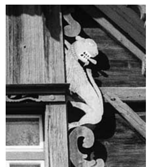
Hölzerne, gesägte Verzierung an der Rahmung des dreiteiligen Giebelfensters am Bodenhaus, 2. H. 18. Jh., Zustand 2000.
