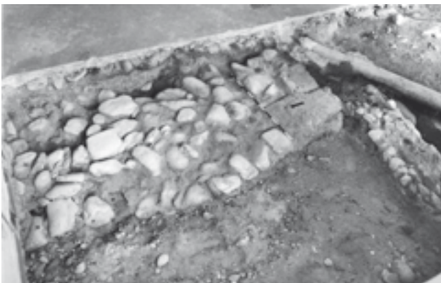
Abb. 40 Rheinau. Ehem. Kloster. Ehem. Schenkkeller (Abwaschraum, Küche). 1991 freigelegte Mauern, von Nordwesten gesehen.
