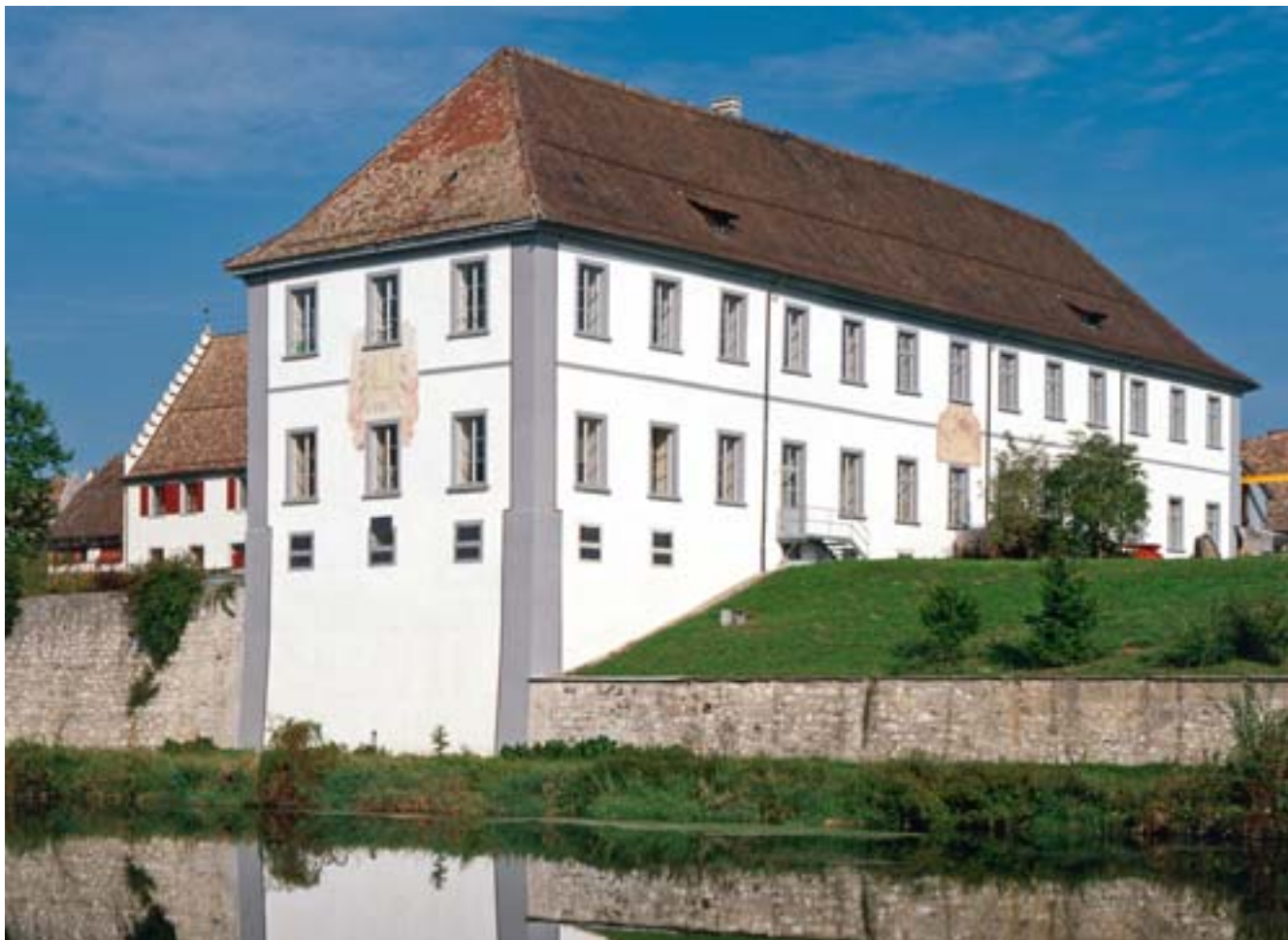
Abb. 1 Rheinau. Ehem. Frauengasthaus des Klosters. Ansicht von Südosten. Zustand nach der Aussenrenovation von 1995/1996. Aufnahme von Kuno Gyga, HBA, September 1997.
