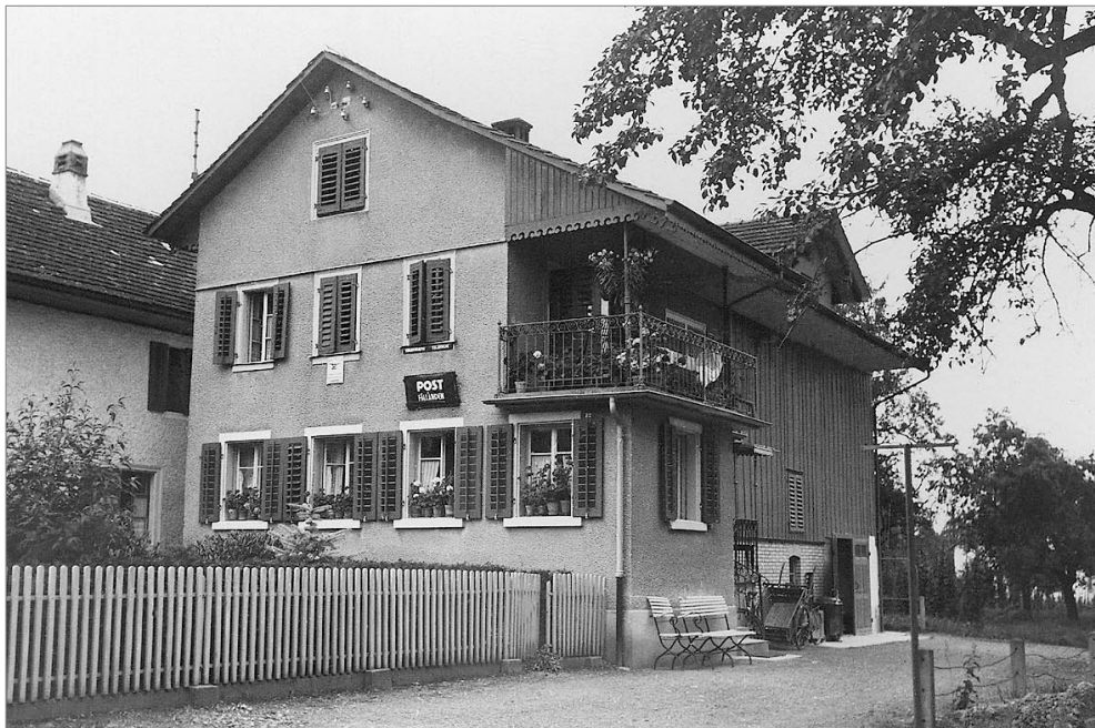
Abbildung 12 Postlokal von 1892-1948 an der Maurstrasse 17. Um der Raumknappheit zu begegnen, errichtete Emil Gachnang 1916 einen An- bau. Darin befand sich das 8m 2 grosse Postlokal.
