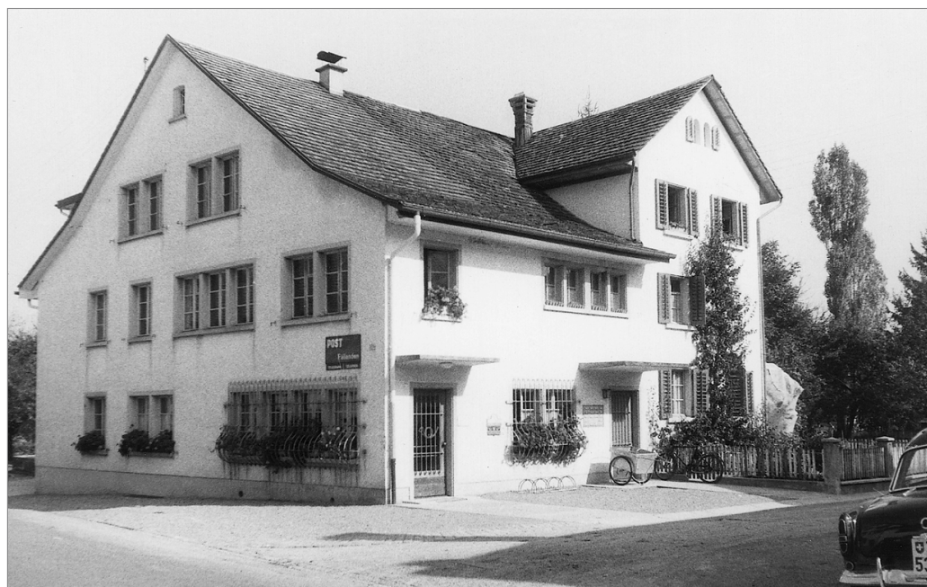
Abbildung 7 Von 1948 bis 1972 befand sich das Postbüro im Hause von Posthalter Willi Schmid an der Schwerzenbachstrasse 8 in einer ehemaligen Wagnerwerkstatt
