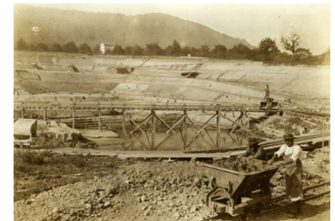
Einstige Lehmgrube in der Binz, Aushub für die Backsteinproduktion (Bild: BAZ_096626)
