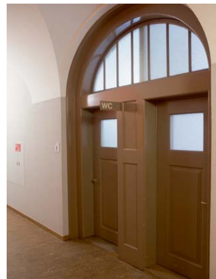
Die 1903–1919 gebauten Amtshäuser der städtischen Verwaltung sind kantonale Schutzobjekte. Brandschutztechnisch aufgerüstete Türen im Amtshaus II erfüllen gleichzeitig die Anforderungen von Feuerpolizei und Denkmalpflege.
