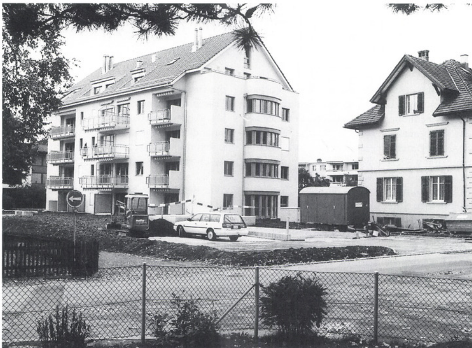
Im Birchlenquartier steht an der Meiershofstrasse das gemeinsam von der Stadt und Fritz und Cornelia Meier-Dübendorfer errichtete Mehrfamilienhaus mit total 16 Wohnungen. Neun davon sind rollstuhlgängig eingerichtete Alterswohnungen, die zu ermässigten Zinsen vermietet werden. Erstmals entstand damit in Dübendorf eine Quartieralterssiedlung.
