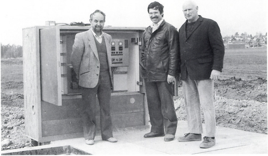
Inbetriebnahme des Pumpwerks. Luigi Costa, Gottfried Stebler, Albert Bertschinger (von links).
